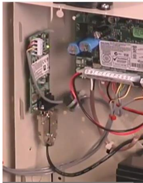
Kuvio 15 IT-100 kytkentäkuva DSC1864 rikosilmoituskeskukseen
