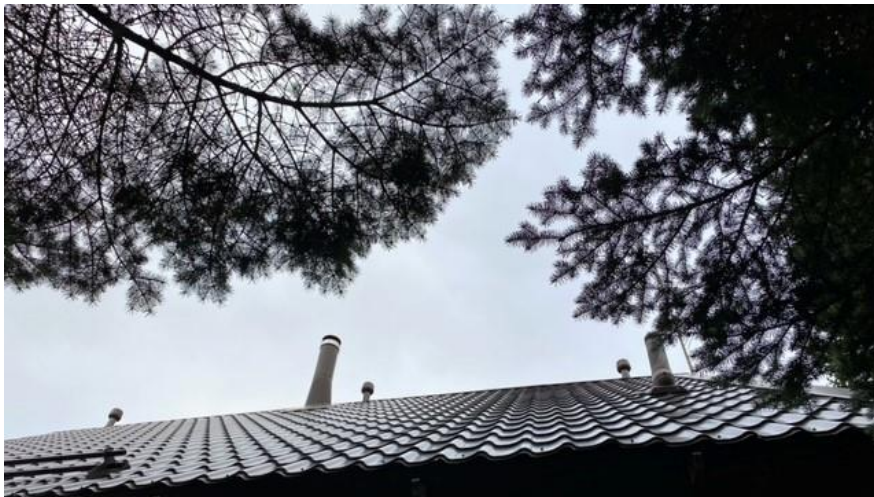
Kuva 10. Asuinrakennuksen katto ilmansuuntaan etelä.
