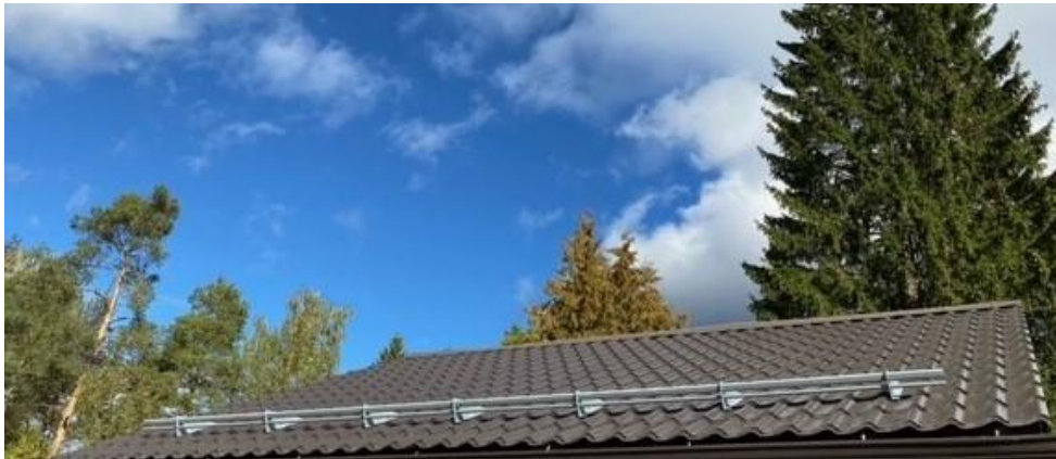
Kuva 9. Autotallirakennuksen katto ilmansuuntaan länsi.
