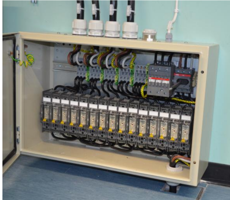
Kuva 4. JK117 testihuoneen ulkopuolisella seinällä
