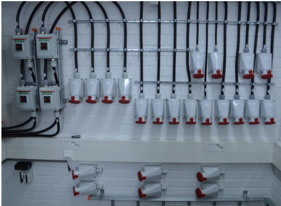
Kuva 1. Testihuoneen peräseinän asennukset
