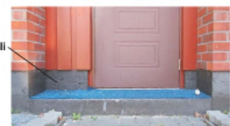
Havainnekuva valesokkelista. Sockkelin yläpinta ylempänä oven kynnystä.
