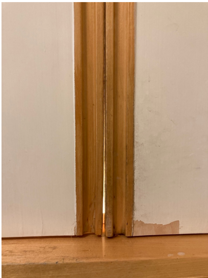
Kuva 26. Ennen ja jälkeen-kuva puhdistuksesta. Vasemmalla on puhdistettu vedinlista ja oikealla likainen.
