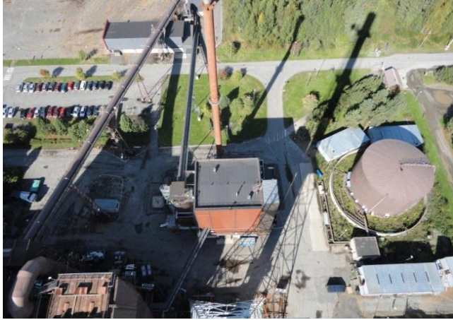
Kuva 3. Biolämpölaitos kuvassa keskellä [2]
