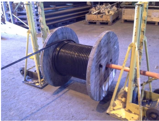
Kuva 6. Kaapelikela on nostettu kelapukeilla ylös
