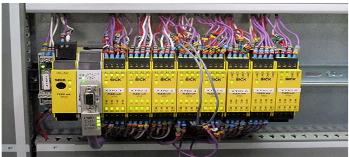
KUVA 1. Sick Flexi-Soft – turvalogiikka laitekaappiin asennettuna /6/
