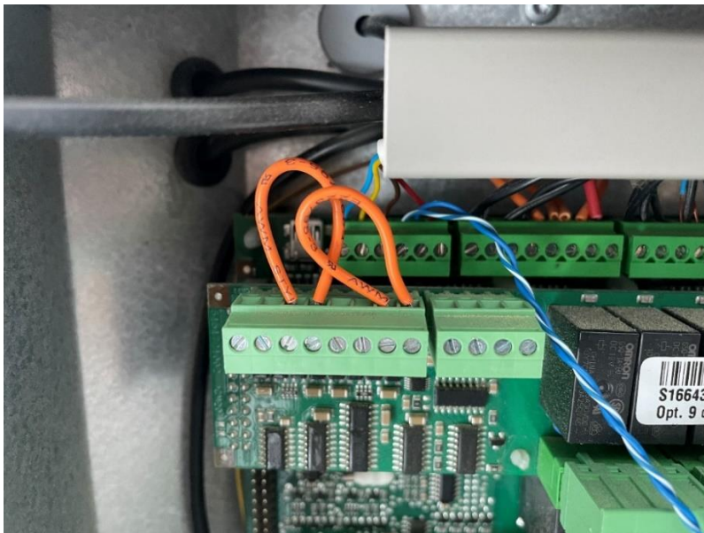
Kuvio 13: Parikaapelin liittäminen poistoilmalämpöpumpun piirikorttiin
