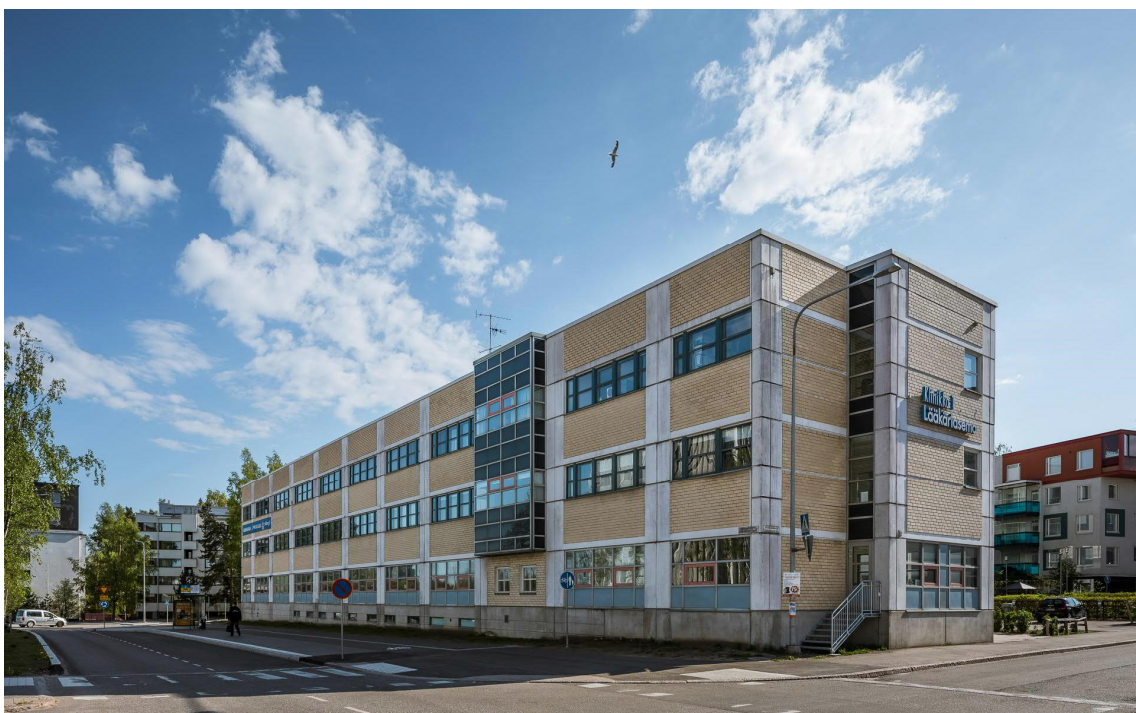
Kuva 8. Kivensilmänkuja 2 pohjoispäätty kadun puolelta 11
