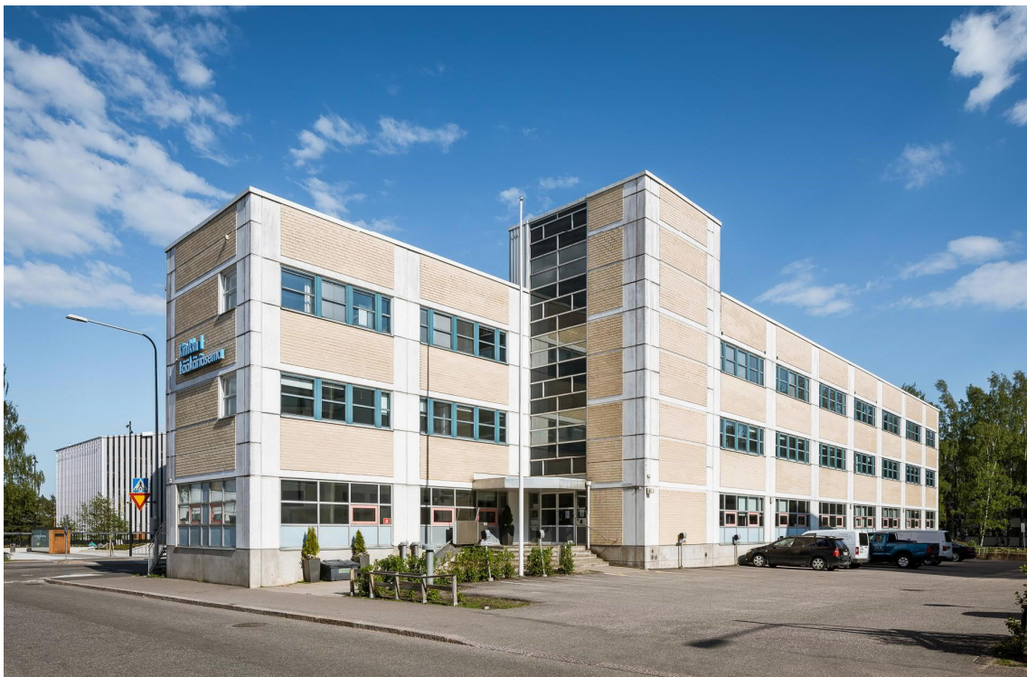
Kuva 7. Kivensilmänkuja 2 pohjoispäätty ja pääsisäänkäynti 10
