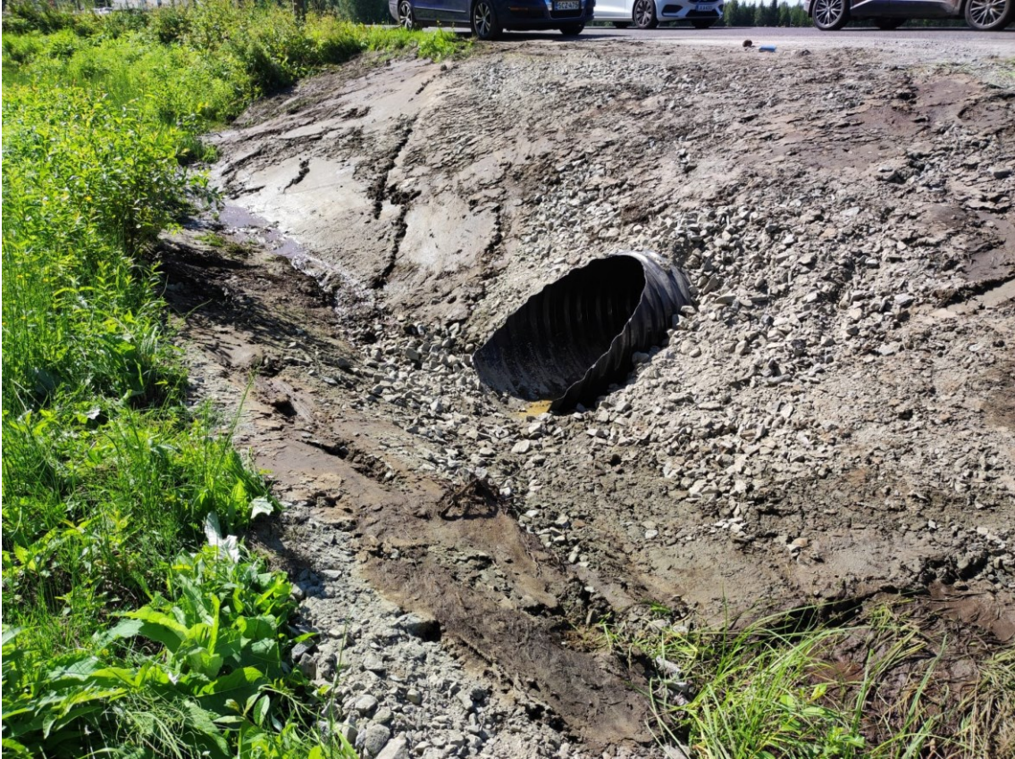
KUVA 12. Teräksisellä rummunjatkolla jatkettu päätierumpu
