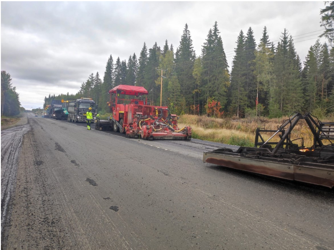
KUVA 34. Kuvassa näkyy punainen MPKJ-laite, jonka edessä näkyy lämmitin. MPKJ-laitteen perässä tulee asfaltinlevittäjä, joka levittää lopullisen pintalaatan kuumajyritylle alustalle.
