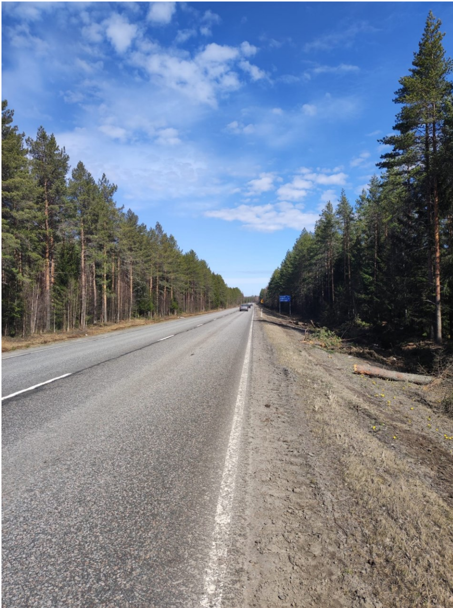
KUVA 6. Valtatie 5 ennen levennystyön aloittamista
