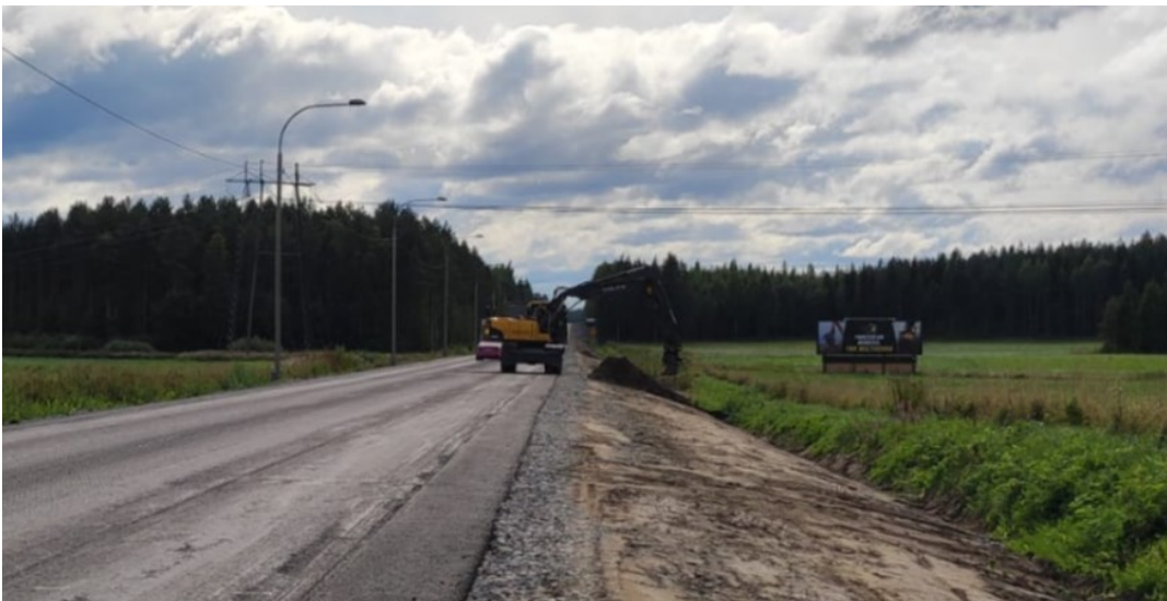
KUVA 31. Kaivinkone kerää ylimääräisiä maita luiskasta
