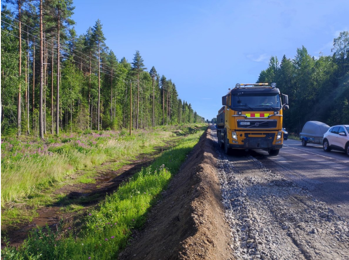
KUVA 19. Reunan tiivistämisessä käytettiin ns. kumipyörätiivistystä
