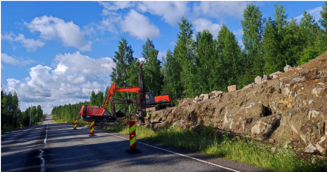
KUVA 37. Kaistoja kavennettu lamellien avulla
