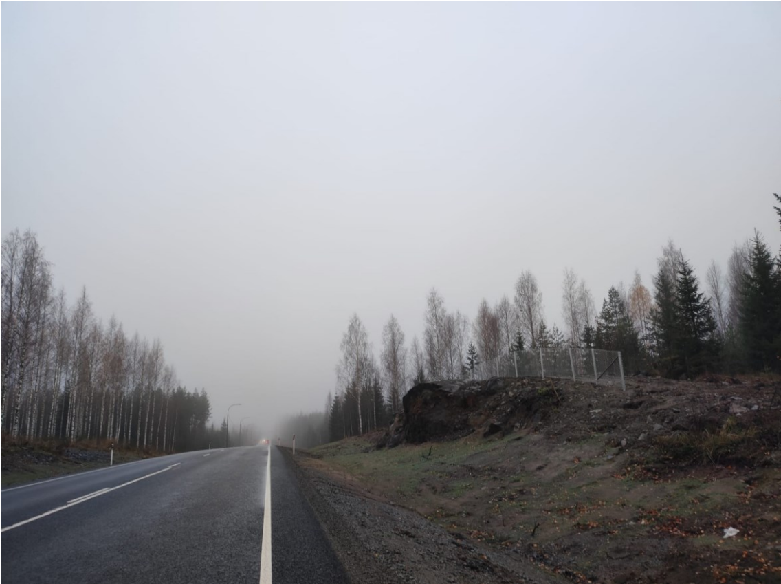
KUVA 24. Kallioleikkauksen päälle asennettiin suoja-aita estämään mahdollinen putoaminen
