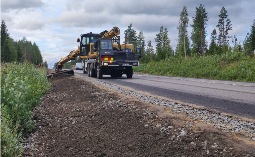
KUVA 30. Gradall luiskakone viimeistelee tien sisäluiskaa
