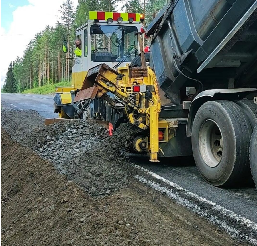
KUVA 18. Tiehöylällä aukaistu reuna täytettiin reunantäyttökoneella
