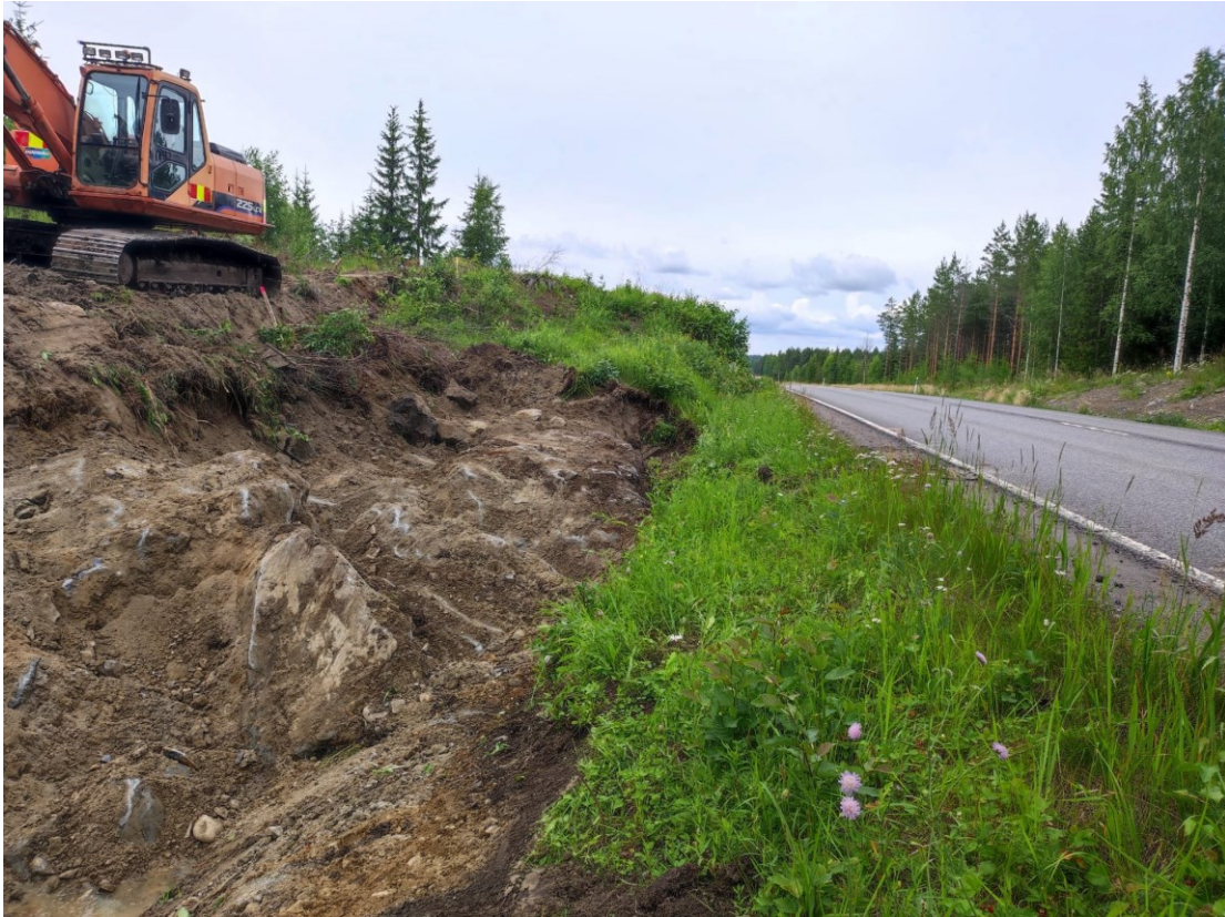
KUVA 20. Pintamaiden poistoa kaivinkoneella
