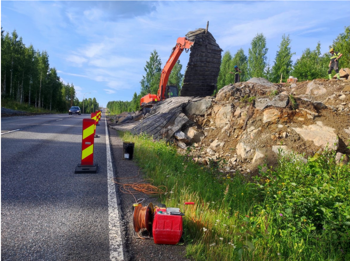
KUVA 23. Kaivinkone nostaa suojaamisessa käytettävää kumimattoa paikoilleen
