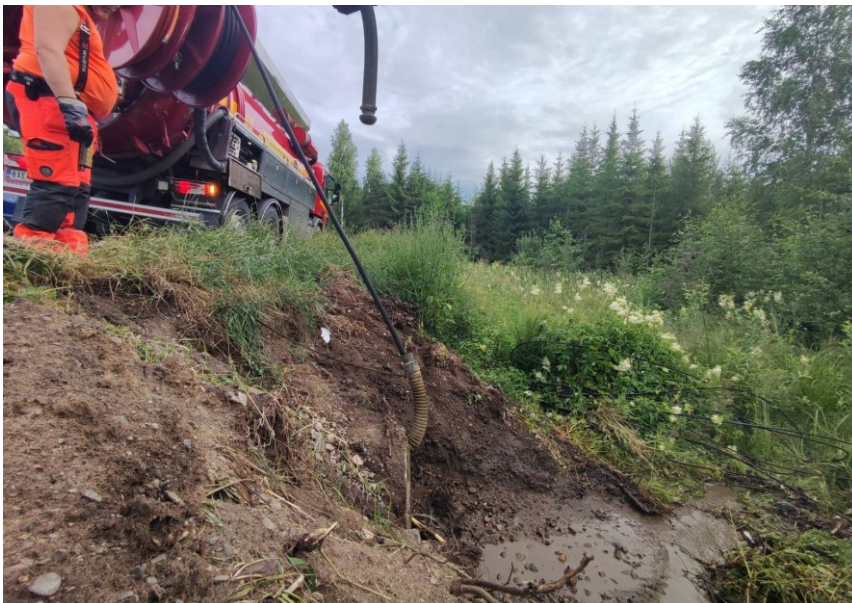
KUVA 11. Imupaineauto huuhtelee tukkeutunutta päätierumpua
