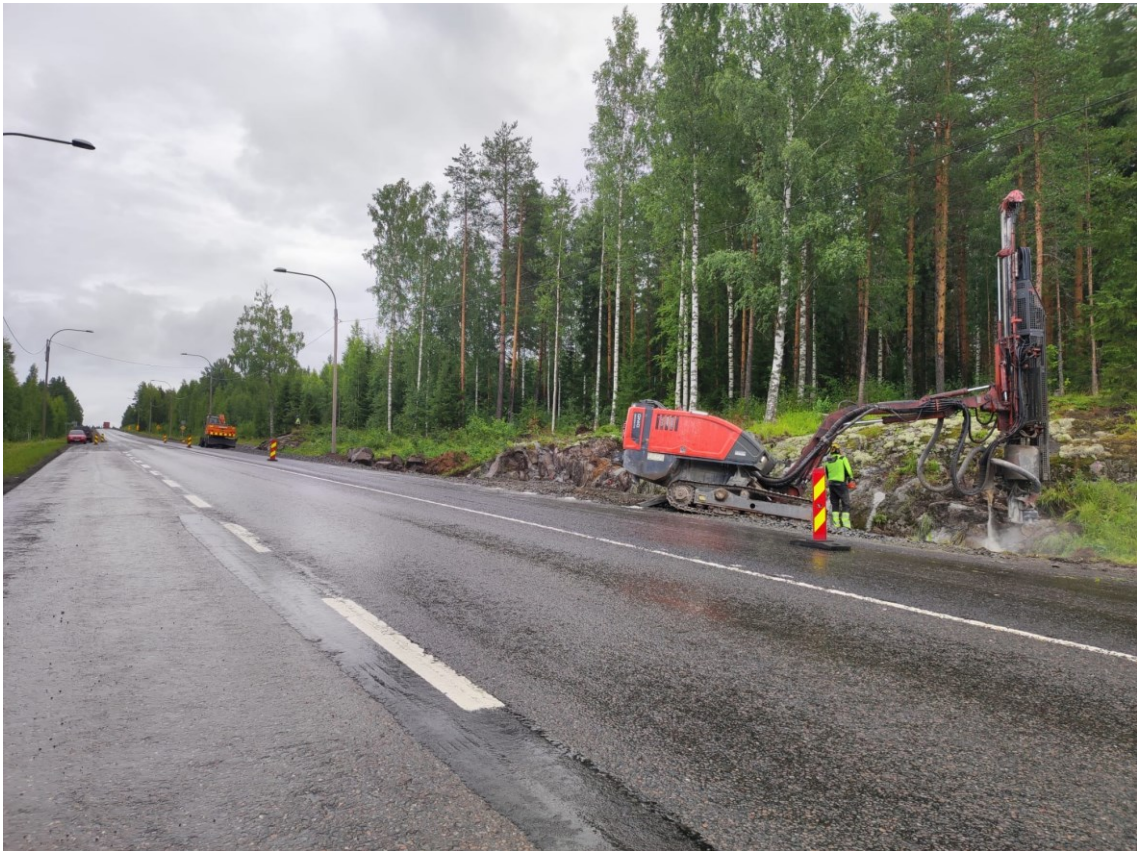
KUVA 22. Poravaunu DINO 400 RI työssään
