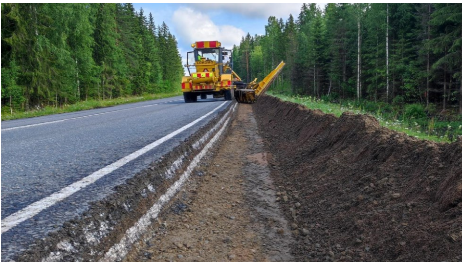
KUVA 17. Tiehöylällä tien reuna saatiin avattua nopeasti ja laadukkaasti
