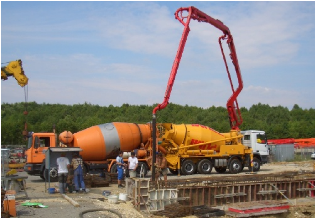
Kuva 5. Pyörintäsäiliöauto ja PUMI valukohteessa (Putzmeister)
