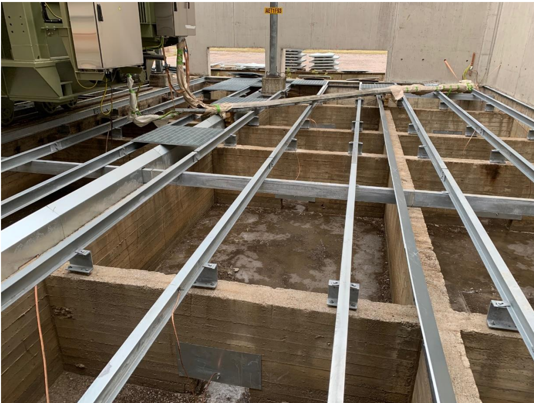
Kuva 5. Valmis koottu Liekkiloukun runko kiinnitettyä betonirakenteisiin (Fintekra, 2022e).
