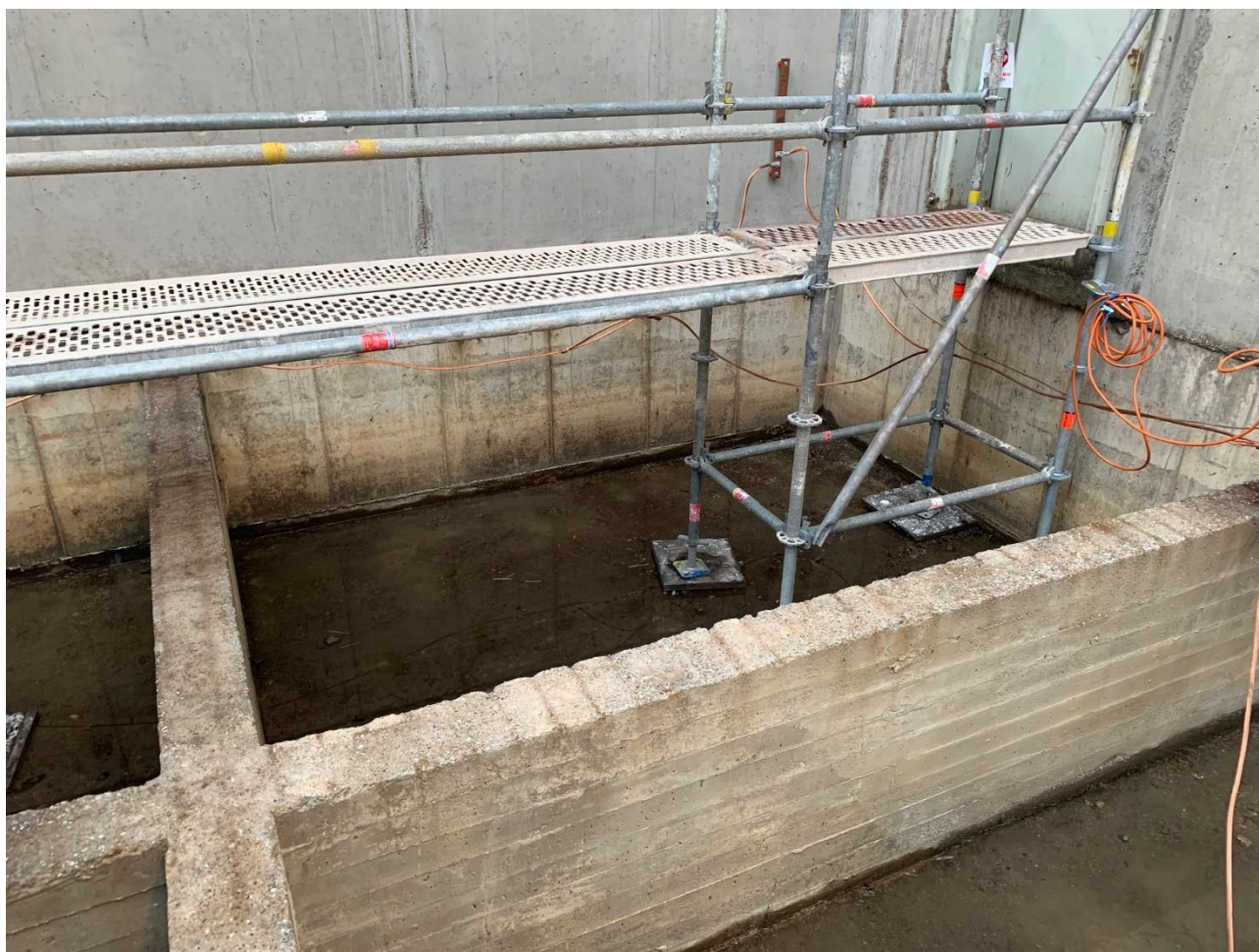
Kuva 6. Betonista rakennettu valuma-allas, jossa näkyy asennusaikainen kulkutaso (Fintekra, 2022f).
