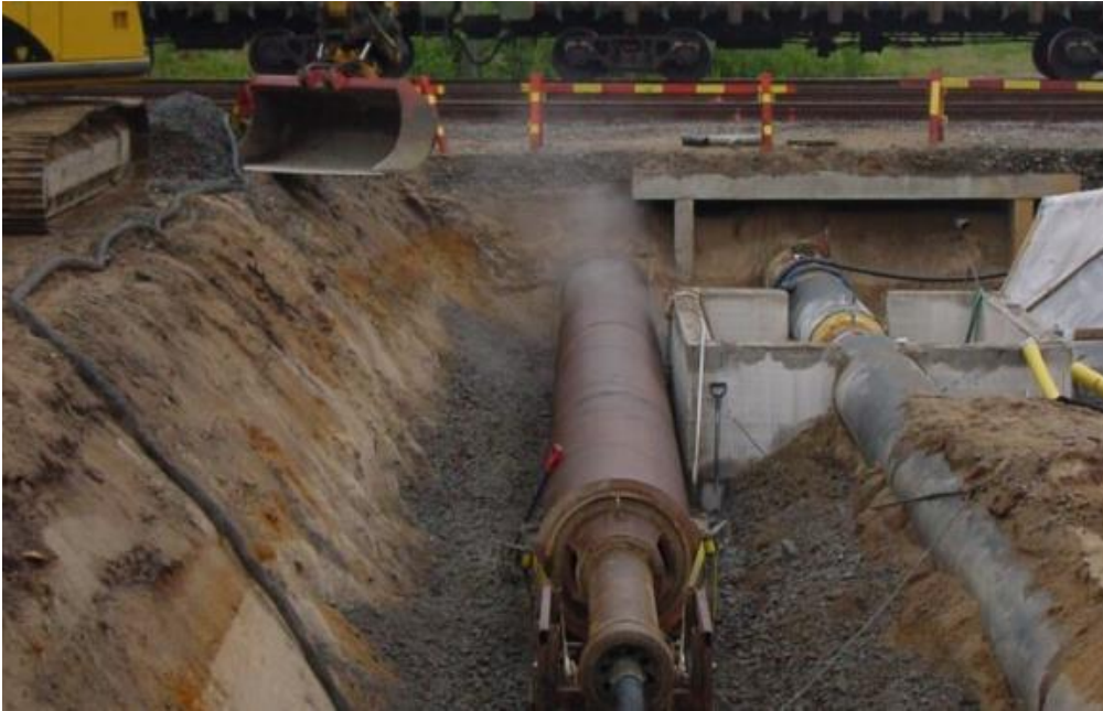
Kuva 11. Kaukolämpösuojaputken asennus juntaamalla (Dahlbacka, Maanrakennus Dahlbacka, 2022)
