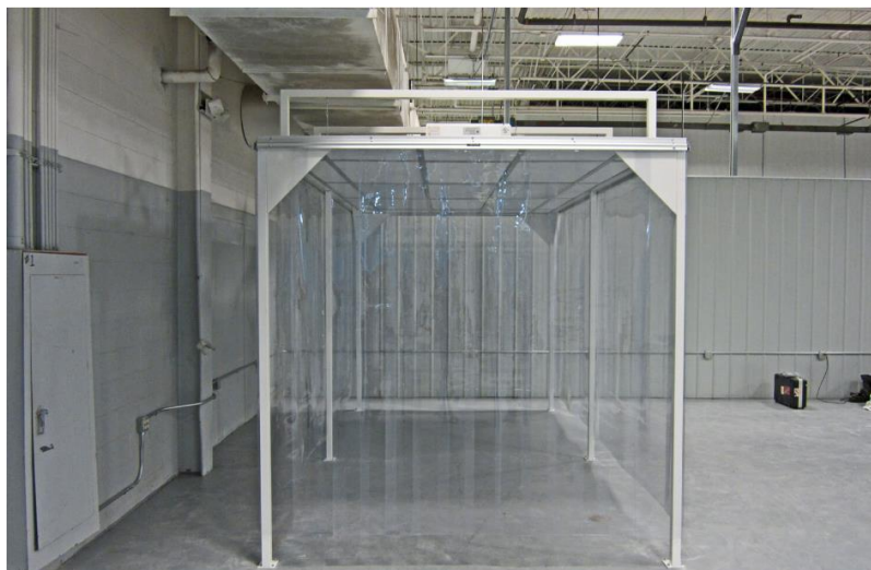
Kuva 15. pehmytseinämäinen modulaarinen puhdastila. (Clean air technology inc. 2022)
