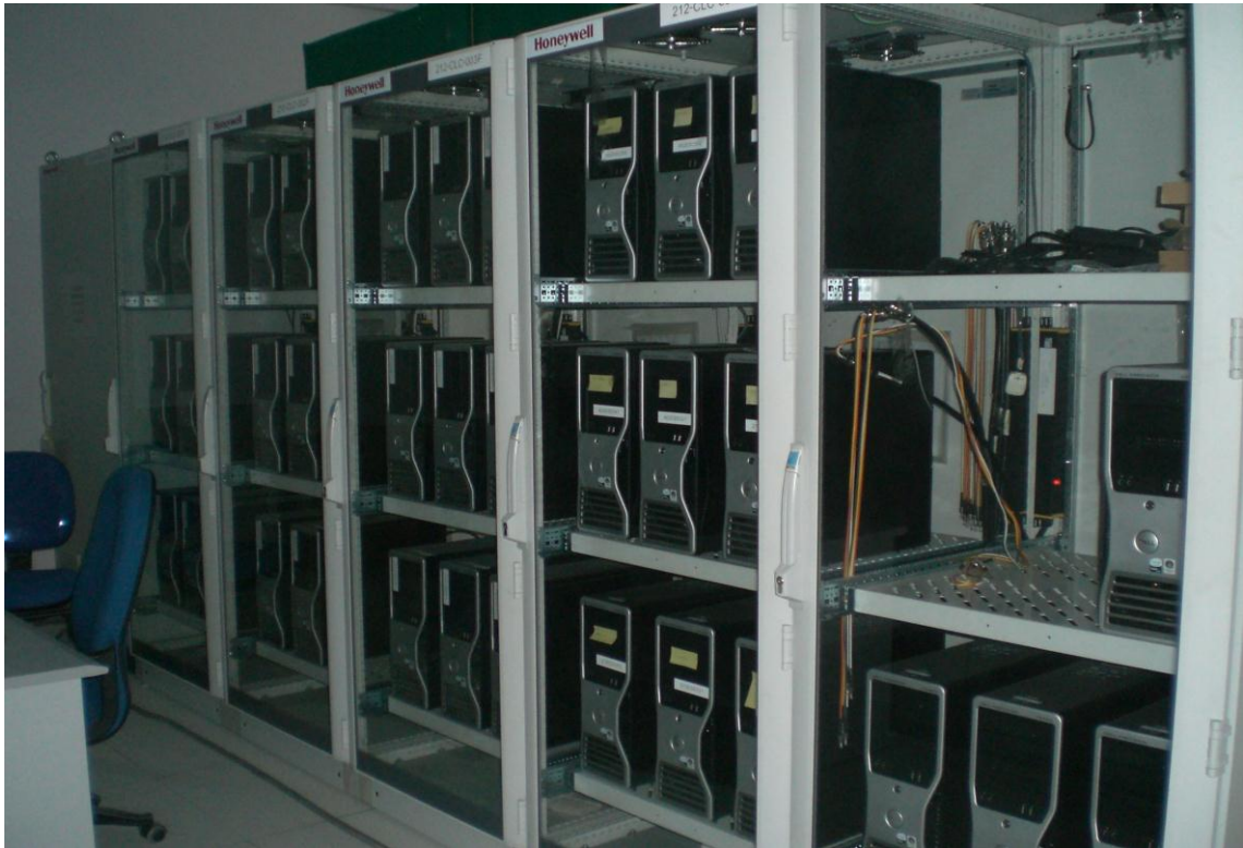
Kuvio 2. DCS:n operointiasemat, perinteinen toteutus. Näytöt ja input-laitteet ovat kytketty KVM-adaptoreilla
