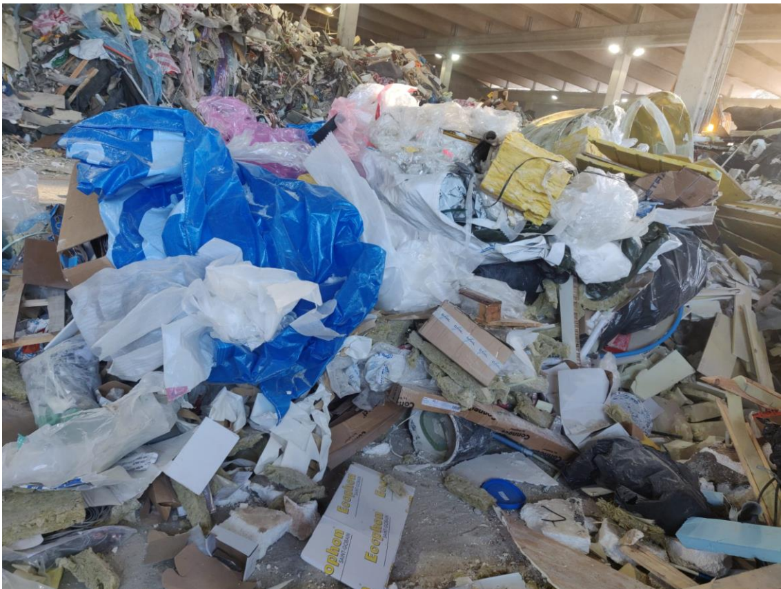
KUVA 7. Työmaalla syntynyttä rakennusjätettä.
