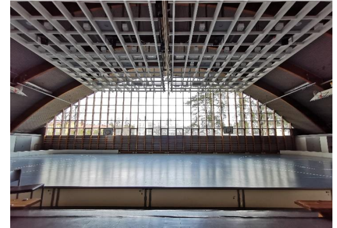
Kuva 3 Kaarirakenteet näkyvät myös rakennuksen sisällä
