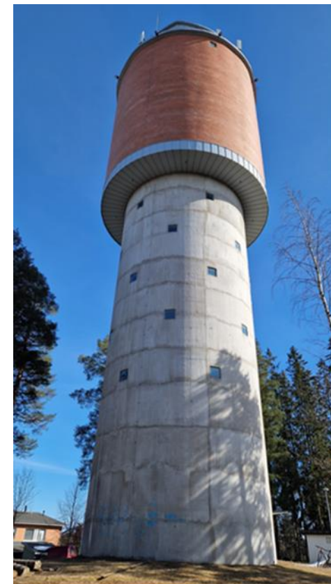
Keravan vesitornin pääjulkisivumateriaaleina toimii tiili sekä betonirappaus. Kuvassa Keravan vanha vesitorni.
