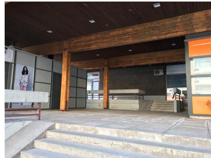
Kuva 1. Kuohukujan ostoskeskuksen tärkeitä ominaispiirteitä ovat näkyvä rakenne ja kävelyterassi osana sisä- ja ulkotilat käyttävää tilasarjaa.
