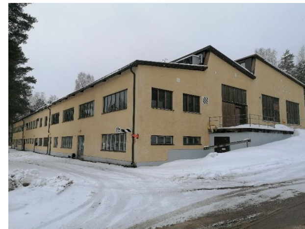
Valokuva rakennuksen pohjois-päädystä. Kuva 1
