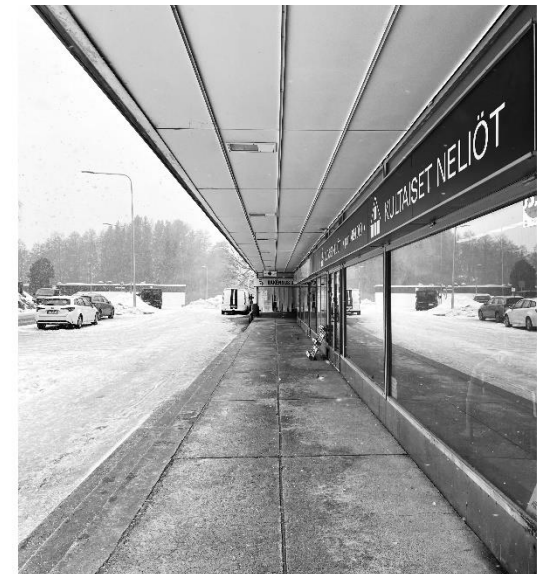
Modernit rakennusmateriaalit yhdistyvät linjakkaassa, horisontaalisessa arkkitehtuurissa. Kuva 4
