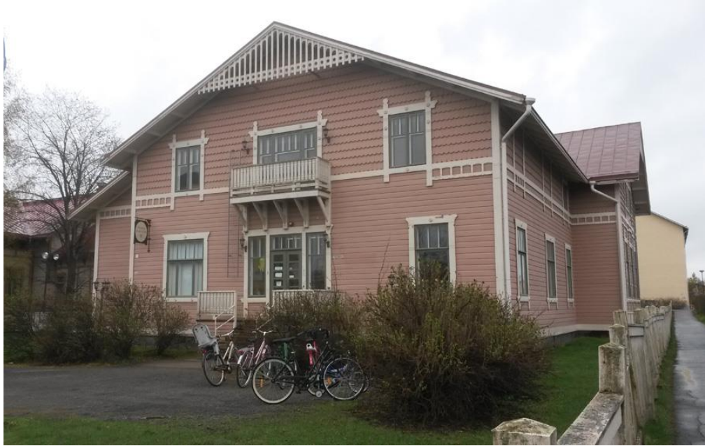
Kuva 7. Päiväkoti Augustina. ReTyykin tilat sijaitsivat rakennuksen toisessa kerroksessa. (Kuva: Heinilä 2014)
