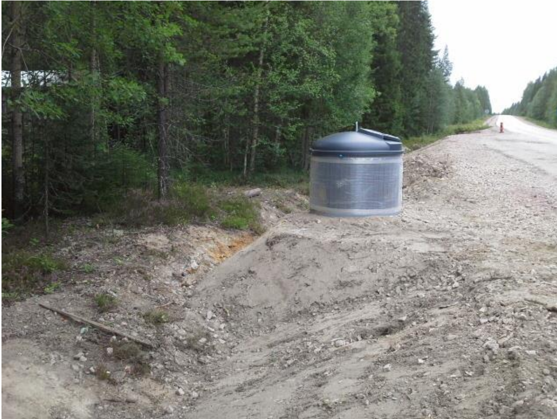
KUVA 9. Roska-astia asennettu. Roska-astian taakse tulee katos ja pöytäryhmä. Levennyksen kohdalla olevaan ojaan olisi hyvä laittaa rumpuputki (kuva Seppo Nuorala)
