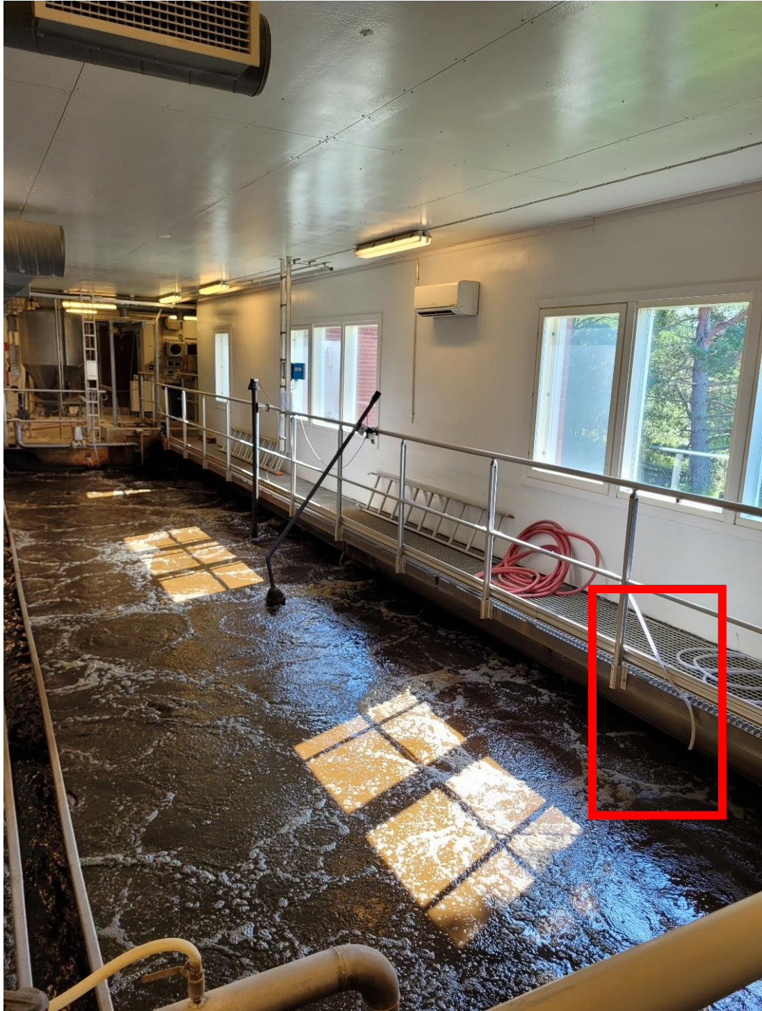
Kuva 22. Saostuskemikaalin kaksipistesyöttö. Toinen syöttöpiste ilmastusaltaan loppupäässä.
