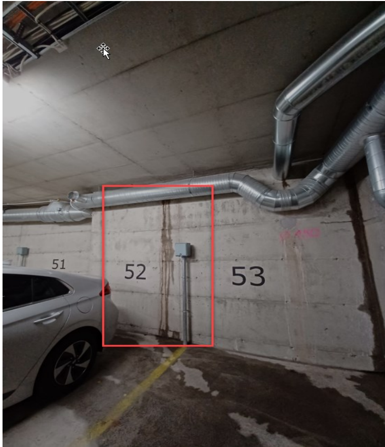
Kuva 18. Autohallin puolella oleva vuoto
