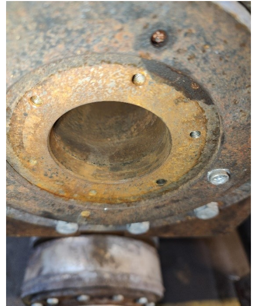
Kuva 68. Pyörivän liittimen paikka, ei syöpymää
