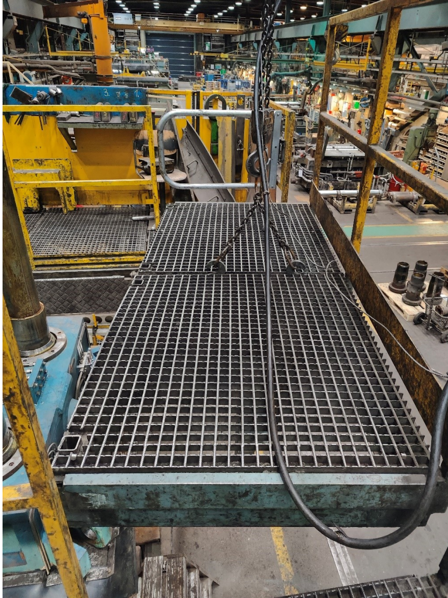
Kuva 29. Huoltotelineen sillan asentaminen.
