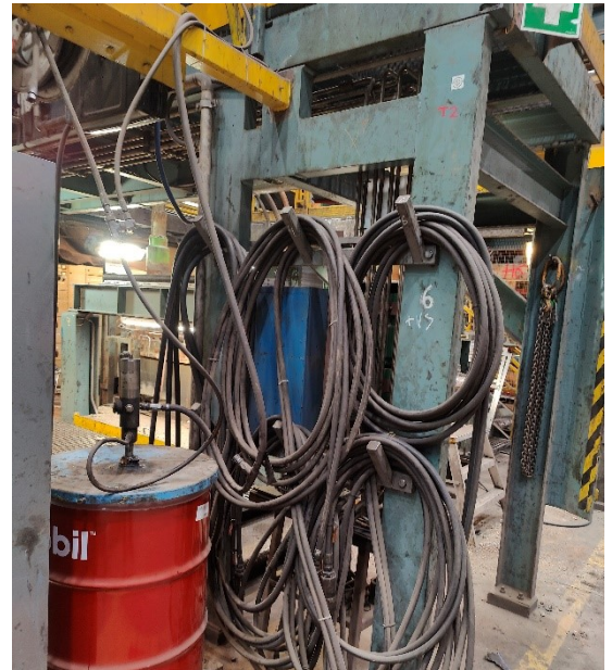
Kuva 23. Hydraulikkaletkut luovutusmittausta varten. Huoltotelineellä olevat letkut kytketään näiden letkujen toiseen päähän painemittarin tolpan vieressä.
