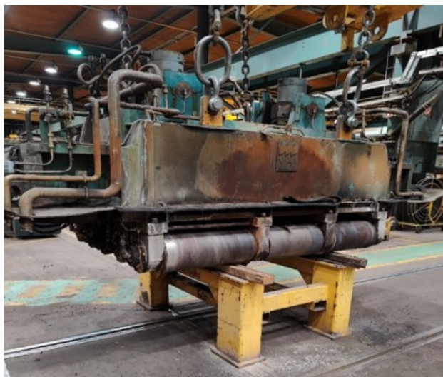
Kuva 38. Yläpuoli huoltopukin päällä purkamista varten.
