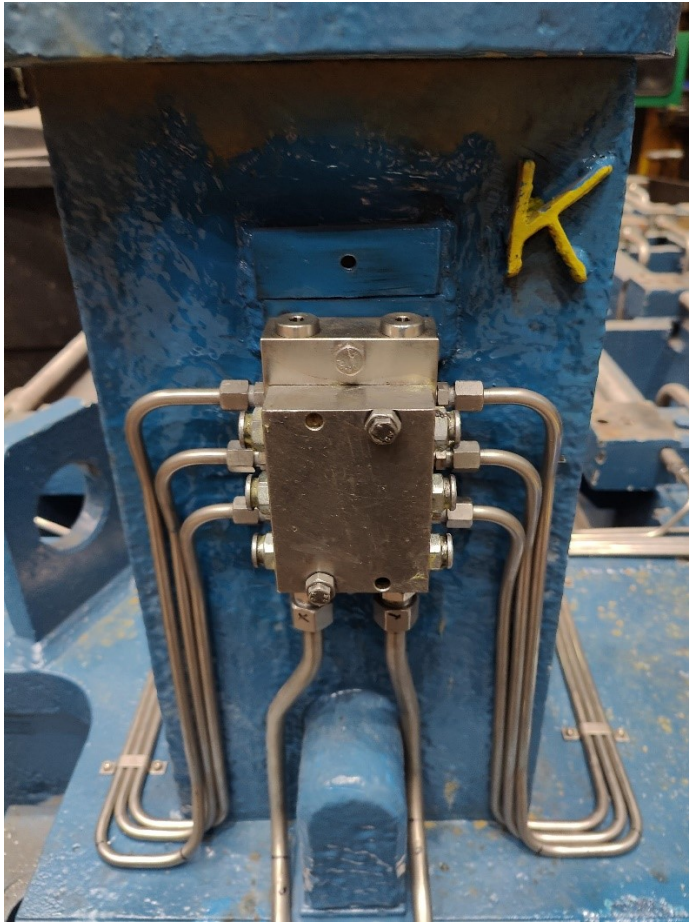
Kuva 64. Rasvauslätkä asennettu rasva-annostelijoiden tilalle
