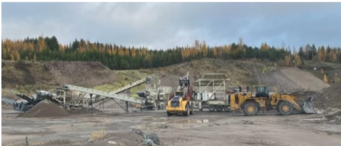
Kuva 12. Urakoitsija murskaamassa. Venäläinen 12.8.2022
