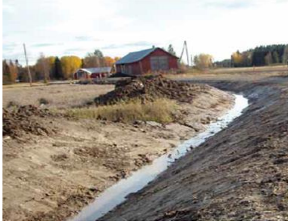
Kuva 16. Sivuojien luiskat kunnostuksen jälkeen (Hämäläinen & Rahja 2012, 36).
