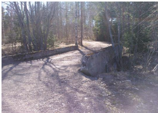
Kuva 13. Vanha betonirunkoinen metsätiesilta (Joonas Lotta, 2014).
