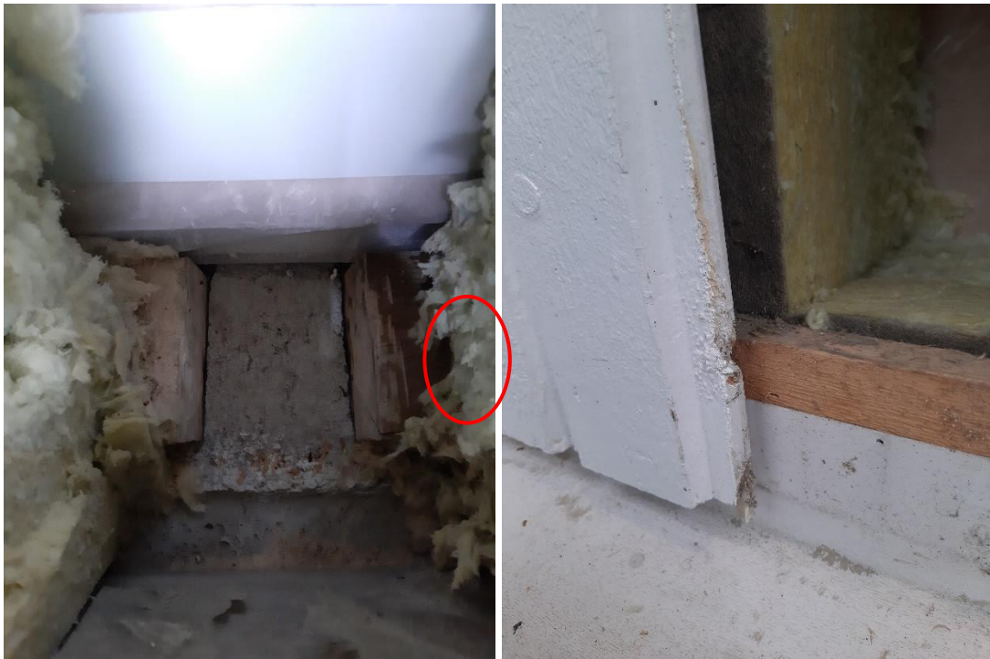
Kuva 19. Yleiskuvaa avatusta rakenteesta. Ympyröidyltä alueelta otettiin materiaalinäyte villasta mikrobianalyysiin. Toisessa kuvassa nähtävissä 20 mm ilmarako tuulensuojavillan ja laudoituksen välissä.
