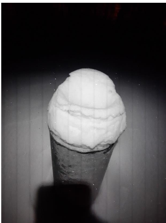
Kuva 21. A-talon viemärin tuuletusputken sulanapitokaapeli ei toiminut ja viemärin pohjalla oli havaittavissa lunta
