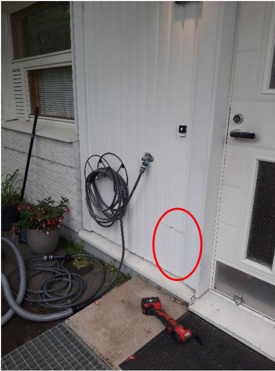
Kuva 18. Avaus tehtiin ympyröidylle alueelle. Vesipiste asukkaiden mukaan tiputtanut vettä
