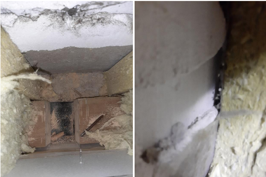
Kuva 15. Yleiskuvaa avatusta rakenteesta. Alaohjauspuun ja sokkelin kapillaarikatkona bitumikermi. Toisessa kuvassa nähtävissä laastin olevan kiinni osittain tuulensuojavillassa
