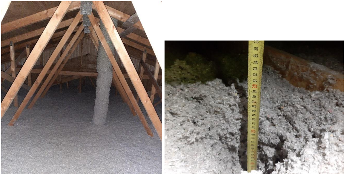
Kuva 11. Yleiskuvaa yläpohjasta. Lisäeristysenä puhallusvillaa asennettu noin 200...250 mm
