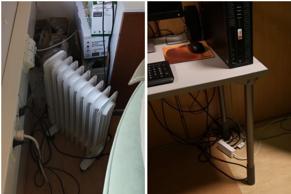
KUVAT 11 ja 12. Lattiapinnoilla varastoituna olleita tavaroita ja sähköjohtoja (Johanna Viitanen 2019).
