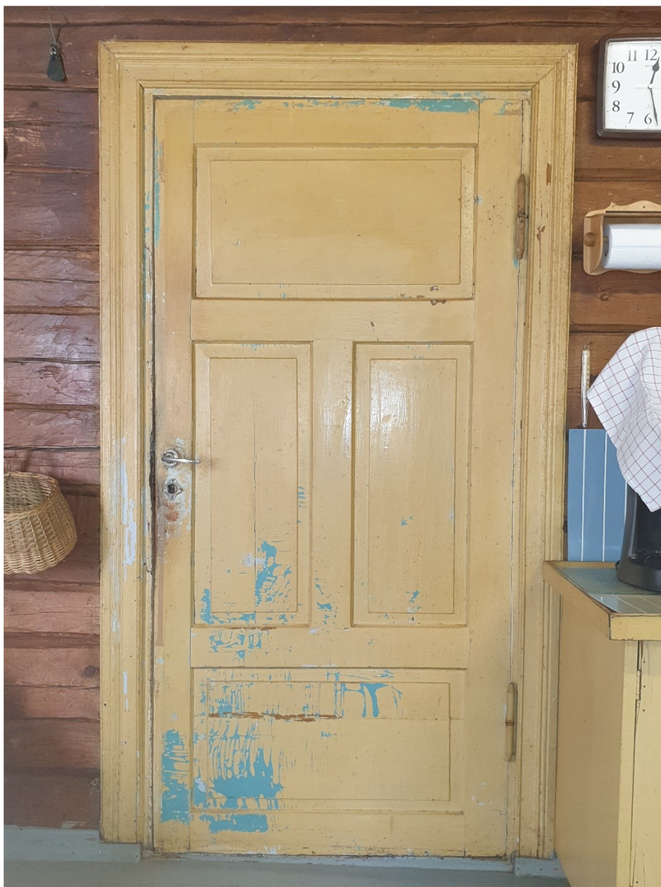
KUVA 17. Tuvan ja kammarin välinen ovi. Halkeilleen maalin alta on näkyvissä aiemmat pintakäsittelyt. (Mäkinen 2022)
