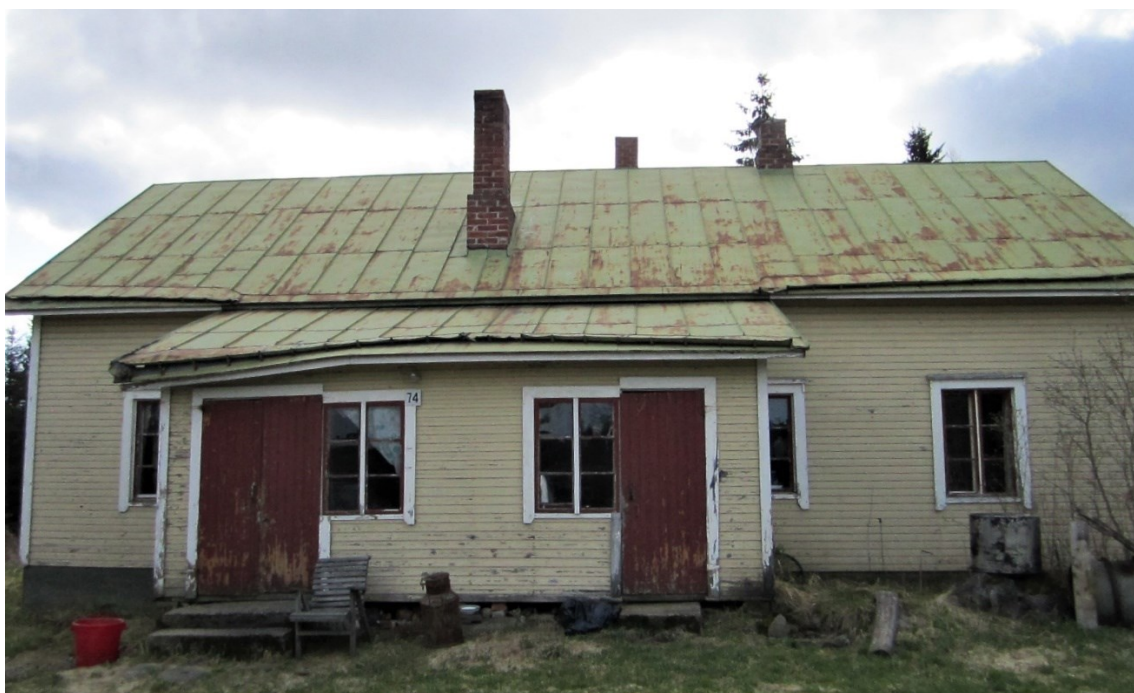
KUVA 10. Laukkalan päärakennus ennen vesikattoremonttia. (Järveläinen 2013)
