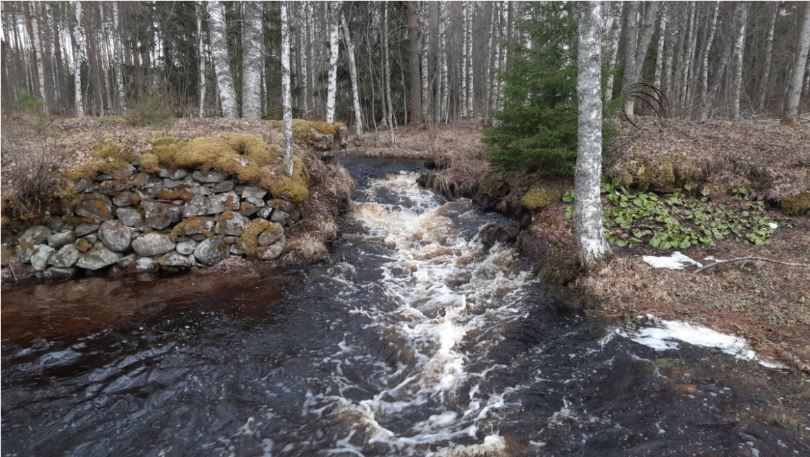
Kuva 17. Jukajoen havaintopaikka "Myllylä 51" kevätylivirtaaman aikana 11.05.2022. Myllyn rakenteiden jätteitä on muokattu kalankulun mahdollistavaksi vuonna 2019.
