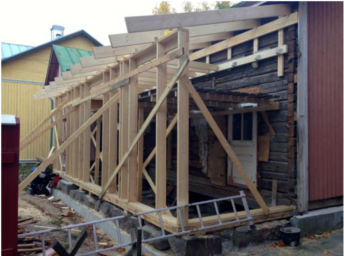
Kuva 1. Laajennus rakennettiin modernilla rankorakennetekniikalla.
