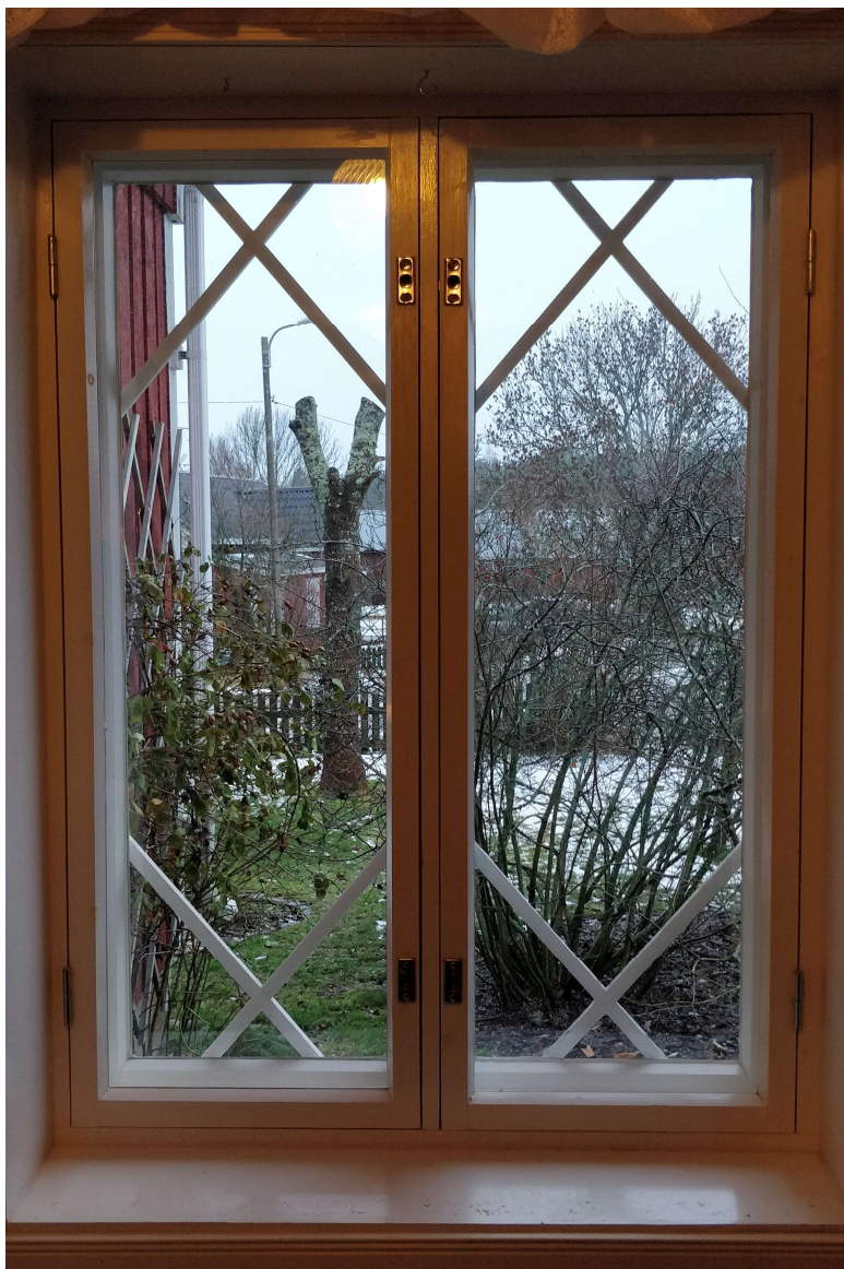
Figur 35. Bild inifrån av fönstertyp 2. (Axén, 2023)
