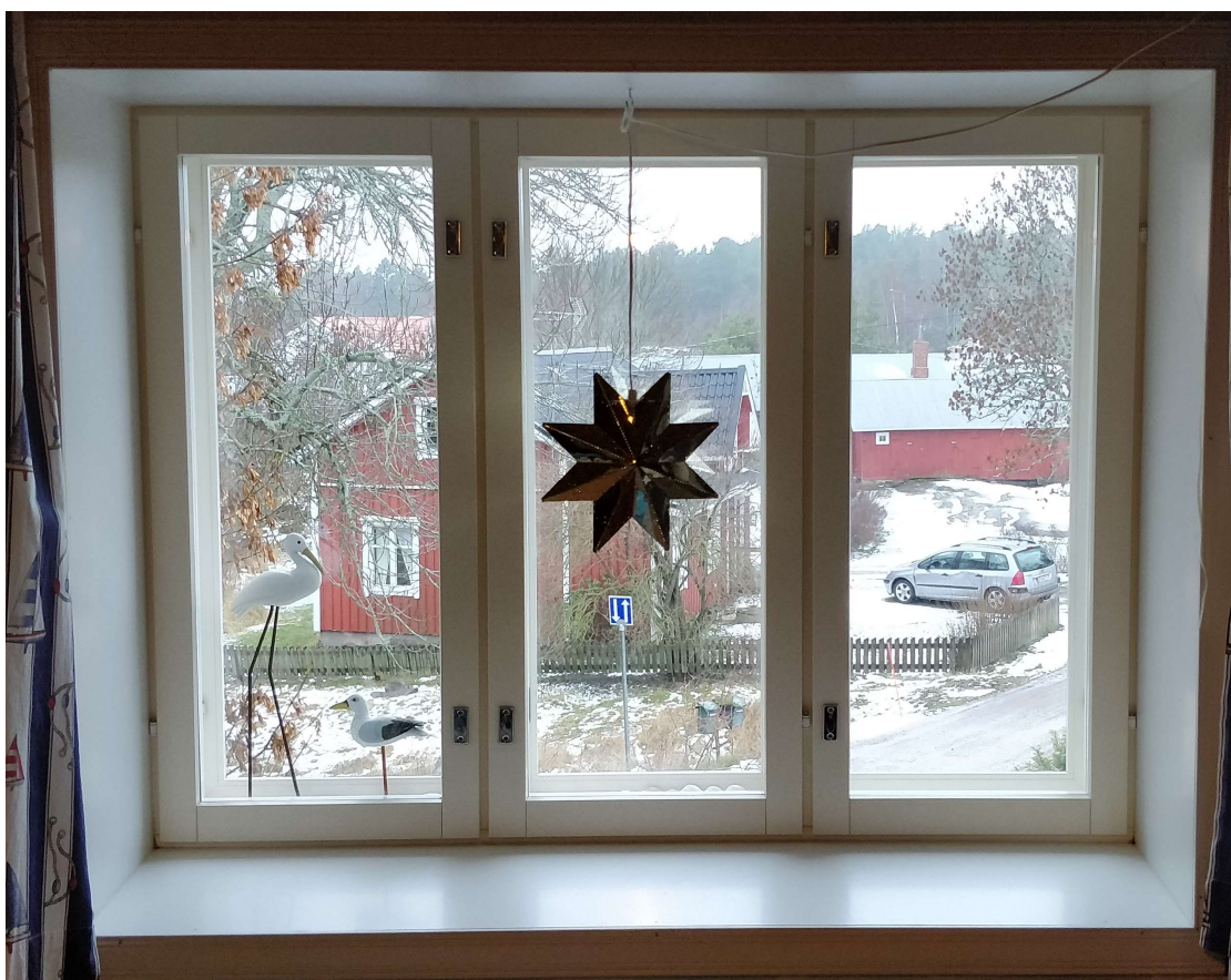
Figur 37. Bild inifrån av fönstertyp 4. (Axén, 2023)
