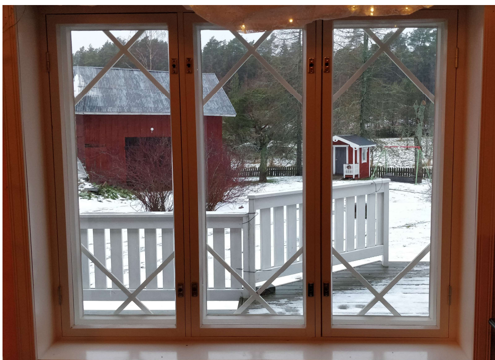
Figur 36. Bild inifrån av fönstertyp 3. (Axén, 2023)
