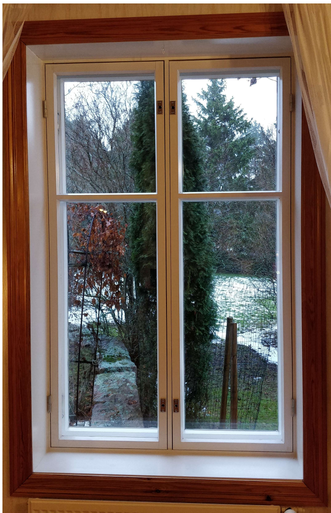
Figur 34. Bild inifrån av fönstertyp 1. (Axén, 2023)
