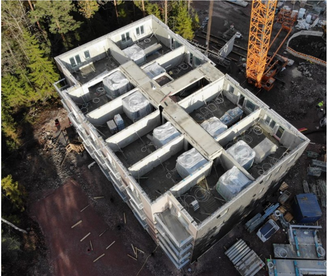
Kuva 9. Kantavilla väliseinillä ja sandwich-julkisivuelementeillä toteutettu runkoratkaisu.
