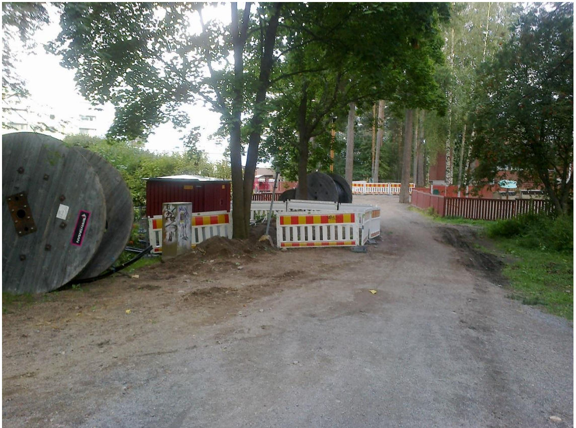
Kuva 3. Pj- ja kj- kaapelointityömaa, korvaushanke ja uusi rengassyöttö yhteys (Mirka Kamarjanskij 2012).
