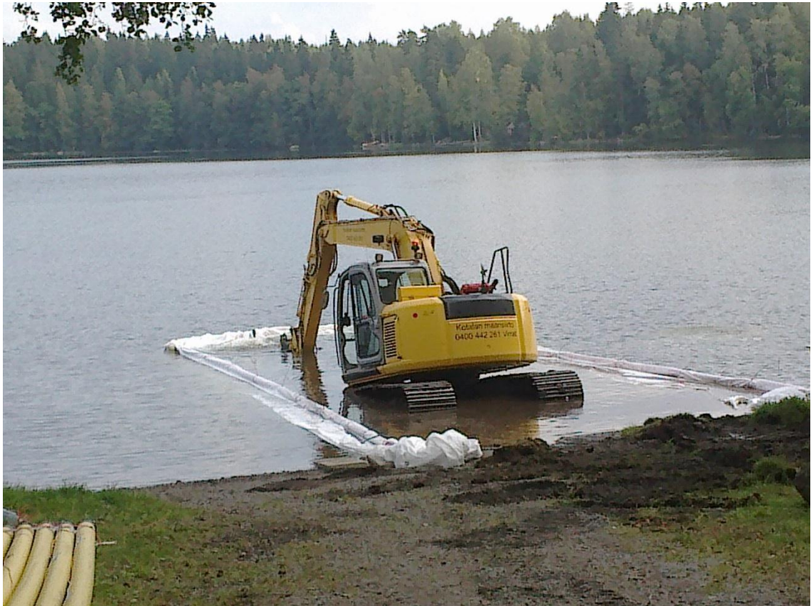
Kuva 5. 20kV uusinvestointikohde, varausputkituksen kaivu (Mirka Kamarjanskij 2012).
