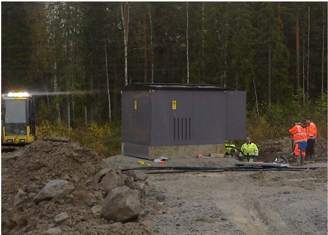
Kuva 4. 20kV kaapelointityömaa, korvaushanke (Mirka Kamarjanskij 2012).
