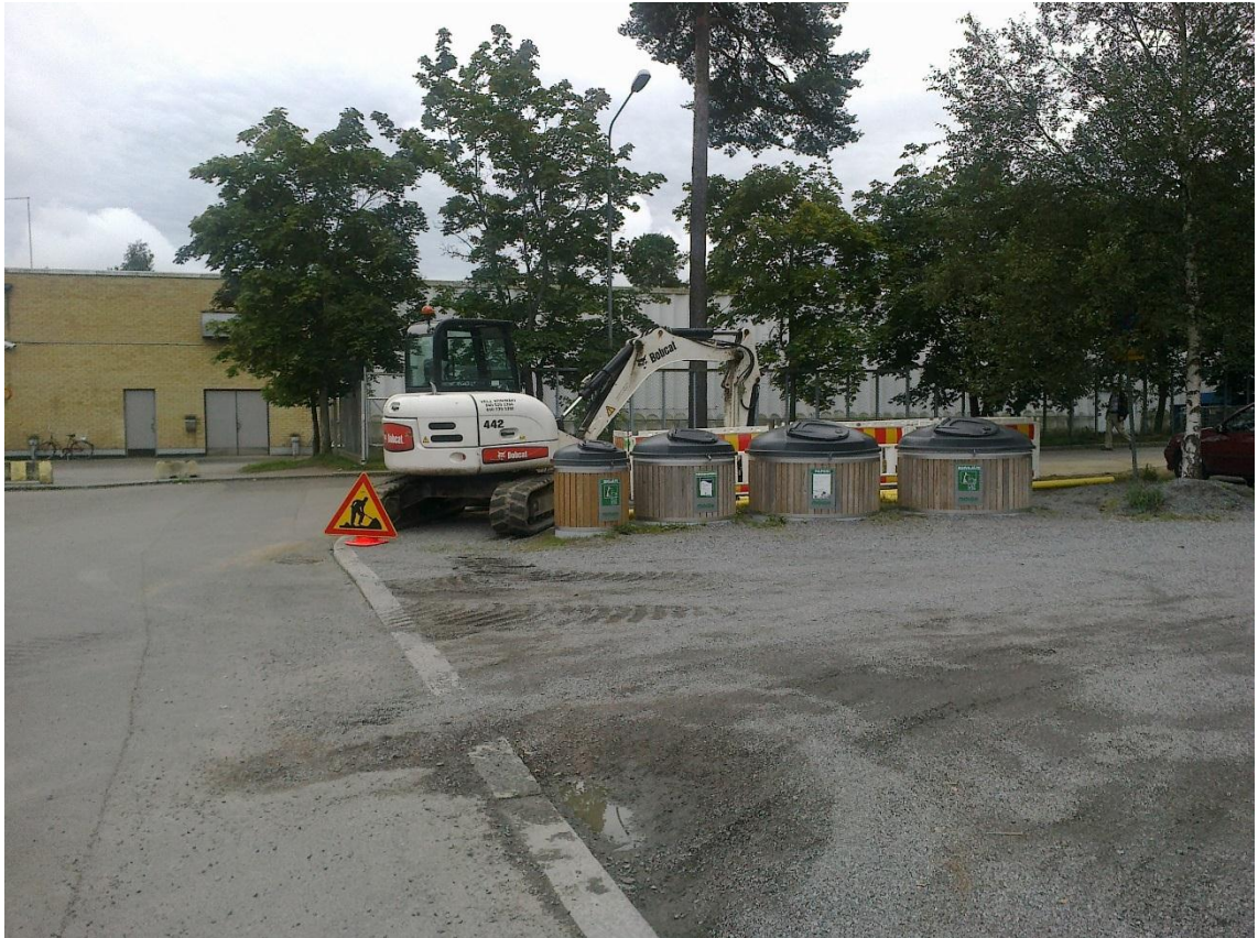
Kuva 1. Uuden jakeluverkon 20kV kaapelin kaivuuta ja putkitusta (Mirka Kamarjanskij 2012).
