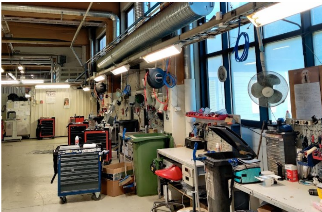
Kuva 30: FAT-testauksen verkkokaapeleita tuotu työpisteille (Torvinen 2021)
