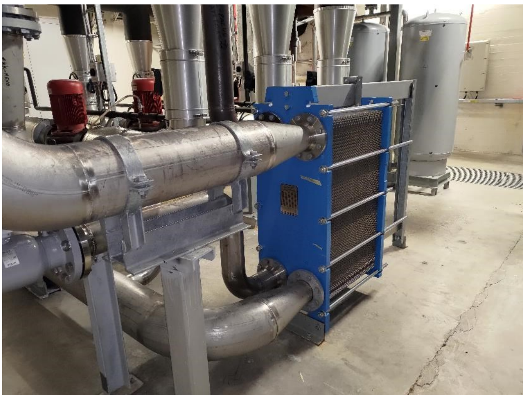
Kuva 12. Lämmönvaihdin, jolla voidaan lämmittää asiakkailta palaavaa kaukojäähdytysvettä kaukolämpöveden avulla. Tämä on hyödyllistä lämpöpumppujen testauksissa.
