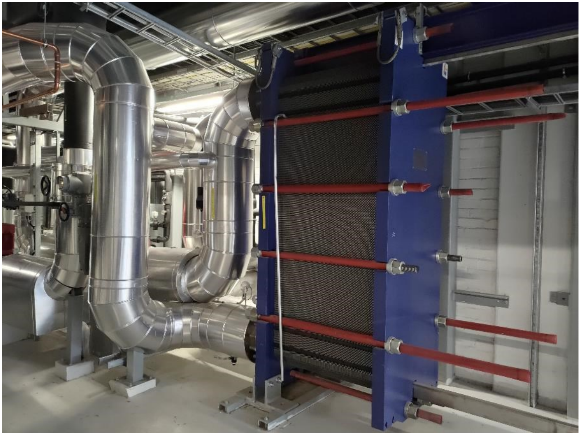
Kuva 5. Nestelauhdutuksen lämmönvaihdin.
