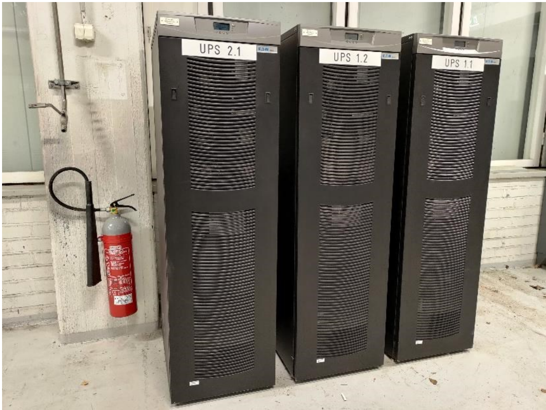
Kuva 10. Kaukojäähdytysveden siirtopumppujen UPS-järjestelmä. Eaton 9355.
