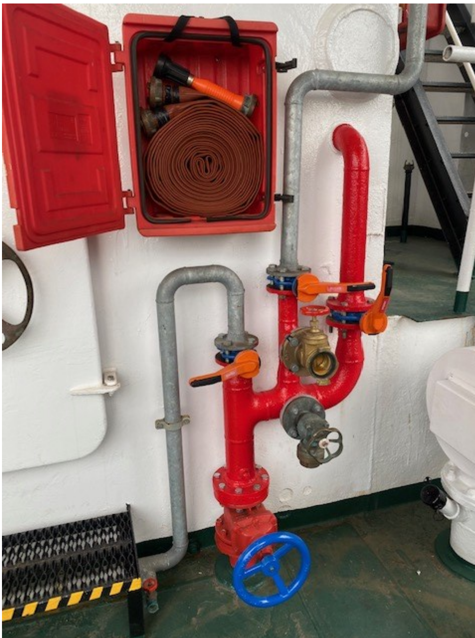
Kuva 12. Paloposti, jossa yhdistetty rantayhde sekä paloletkukaappi (Rautalin 2023).
