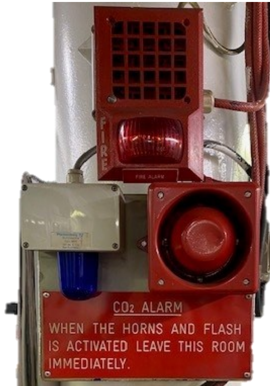
Kuva 8. CO 2 -järjestelmän laukaisun visuaalinen sekä akustinen varoitin (Rautalin 2023).
