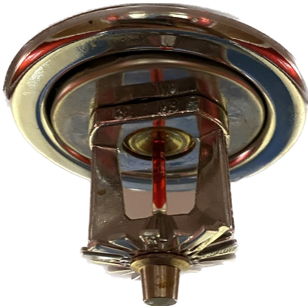
Kuva 11. Sprinklersuutin laivan hyttitilassa (Rautalin 2022).
