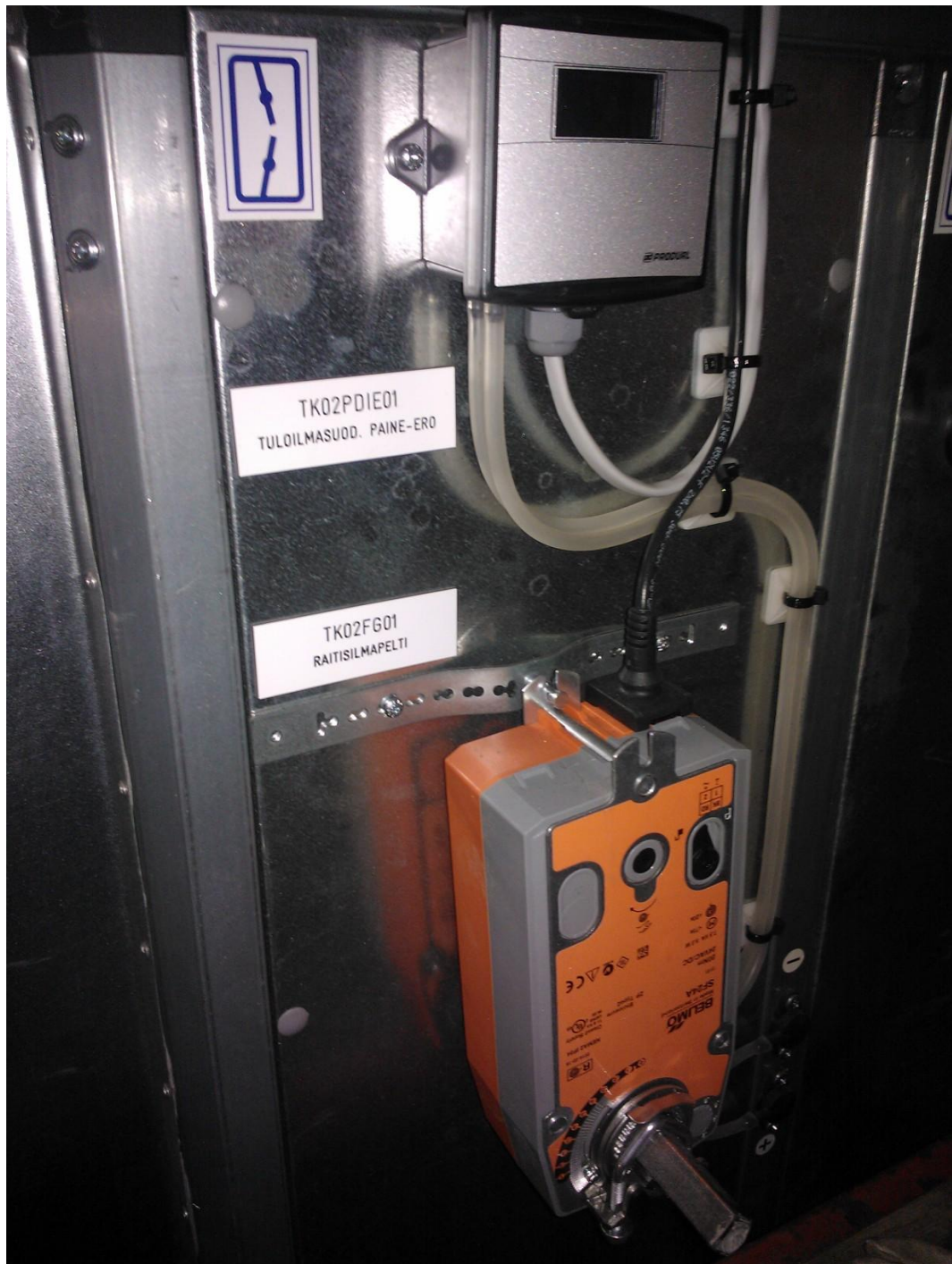
Kuvio 26. TK02FG01-peltimoottori ja TK02PDIE01-paine-erolähetin.
