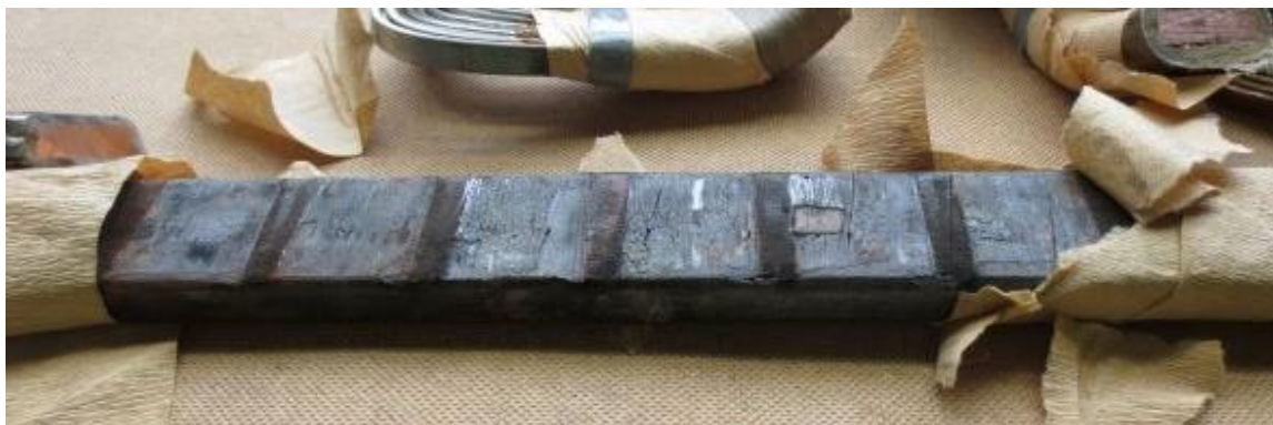
KUVA 24. Värähtelyistä johtuvan hankauksen takia kulunut käämisauva (17)
