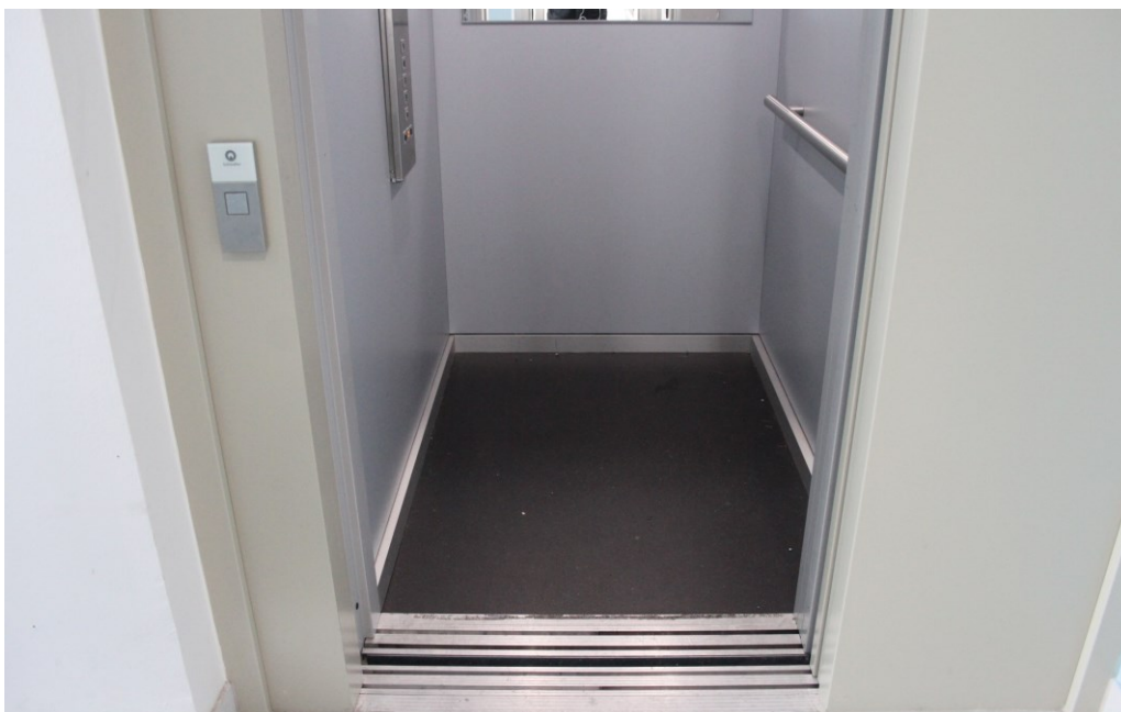
Kuva 39: Asuinkerrostalo, Tampere, 2020. Sekä hissi että seinäpinta on vaalean sävyisiä, jolloin hissi ei erotu seinäpinnasta. (Kuva: Hautasuo, 2023)
