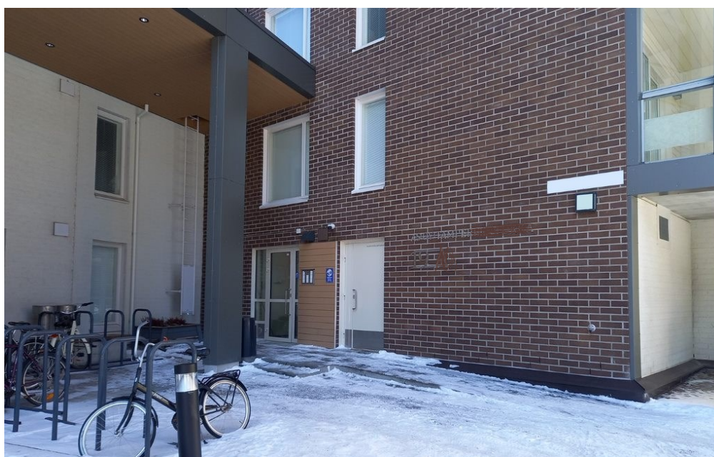
Kuva 15: Asuinkerrostalo, Tampere, 2018. Kyseissä kohteessa sisäänkäynti on todella piilossa kulmassa ja tiiliseinän pinnassa oleva talon nimi ei erotu seinästä yhtään. Osa nimestä peitetty yksityisyyden vuoksi. (Kuva: Hautasuo, 2023)
