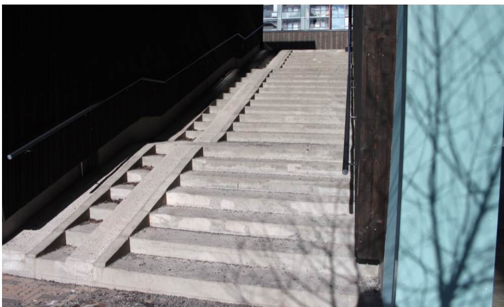
Kuva 30: Asuinkerrostalokortteli, Tampere, 2019. Korttelin kansisisäpihalle ulkokautta oli vain kaksi reittiä, joista toinen oli jyrkkä ajoluiska ja toinen kyseinen portaikko. Sisäpihalle ei siis ollut kunnollista esteetöntä sisäänkäyntiä ulkokautta. (Kuva: Hautasuo, 2023)
