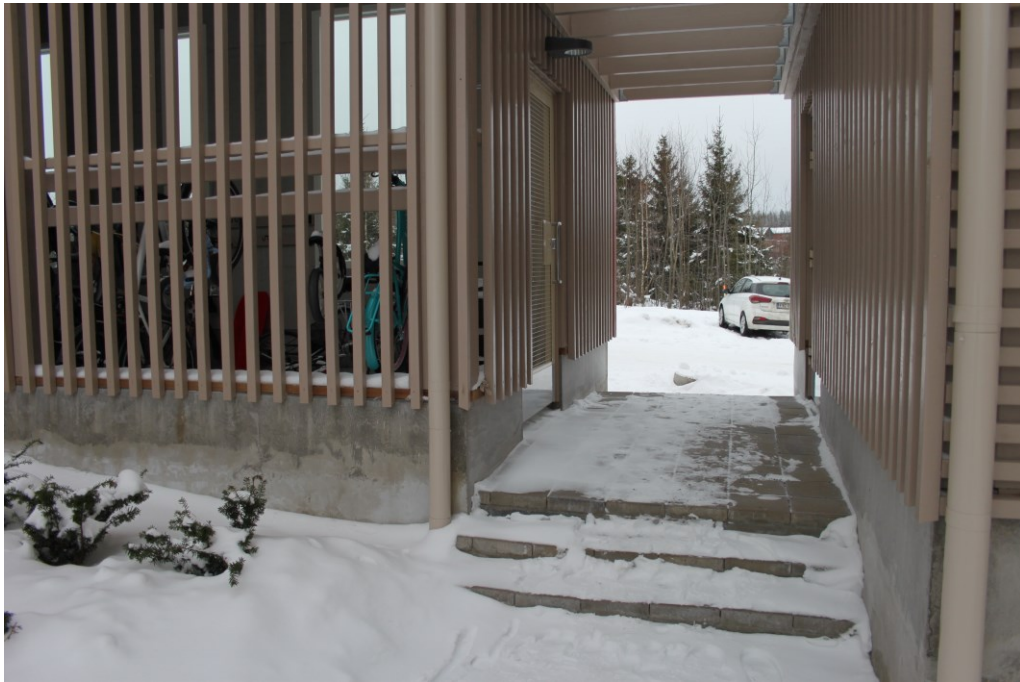
Kuva 20: Asuinkerrostalo, Tampere, 2021. Kulku ulkovälinevarastoon ei onnistunut esteettömästi portaiden takia. (Kuva: Hautasuo, 2023)
