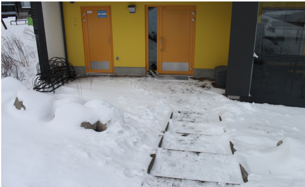
Kuva 21: Asuinkerrostalo, Tampere, 2022. Ulkovälinevarasto sijaitsi sisäpihaa alempana ja sinne kulku on vaikeaa. (Kuva: Hautasuo, 2023)
