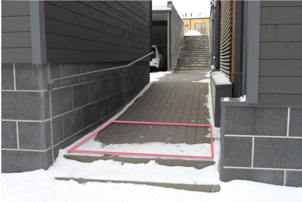
Kuva 23: Asuinkerrostalo, Tampere, 2019. Luiska alkaa jo kuvan ulkopuolelta vasemmalta, ja käänöksessä oleva välitasanne tulisi olla täysin tasainen, mitä se ei tässä ole. Kuvaan piirretty esittämään alue, jossa tulisi olla tilaa tasaiselle vähintään \varnothing 1500 mm kokoiselle pyörähdysympyrälle. (Kuva: Hautasuo, 2023)
