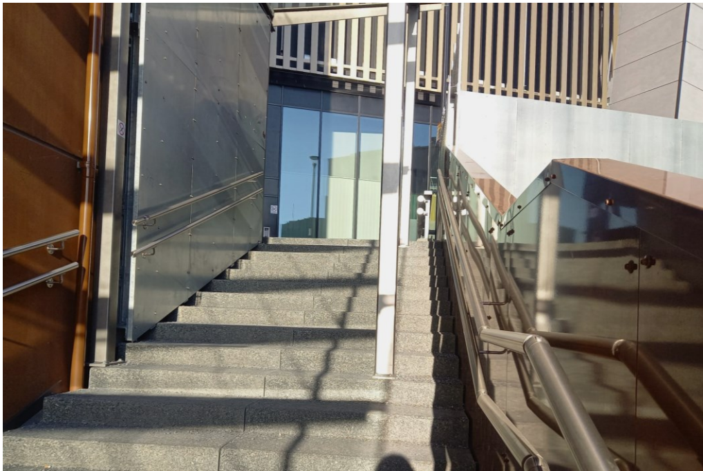
Kuva 25: Asuinkerrostalo, Tampere, 2020. Mikäli kulkee oikeassa laidassa portaita ja pitää käsijohteista kiinni, pilari on suoraan kulkureitillä. Tämä on mahdollinen vaaratilanne näkörajoitteisille henkilöille. (Kuva: Hautasuo, 2023)
