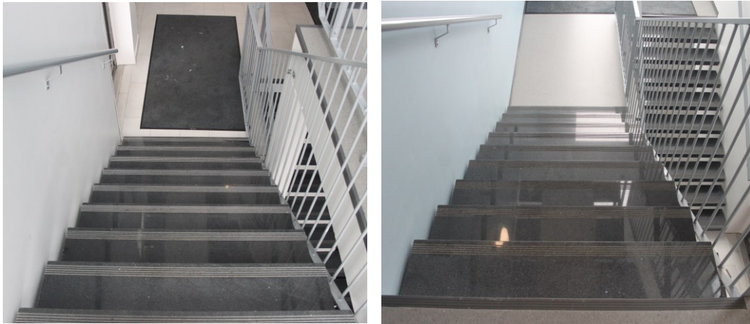
Kuva 37: Asuinkerrostalo, Tampere, 2021. Kontrastiraitoja ei tulisi suunnitella riippuvaiseksi valosta. (Kuva: Hautasuo, 2023)
