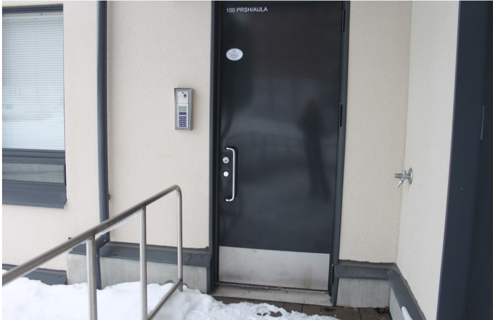
Kuva 33: Vuokra-asuintalo, Tampere, 2021. Toisen rakennuksen pääsisäänkäynnin oven aukeamispuolella ei ole 400 mm tyhjää tilaa. (Kuva: Hautasuo, 2023)
