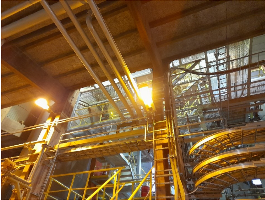
Kuva 15. Ehdotettu paikka uudelle ilmapuhaltajalle alhaalta kuvattuna.
