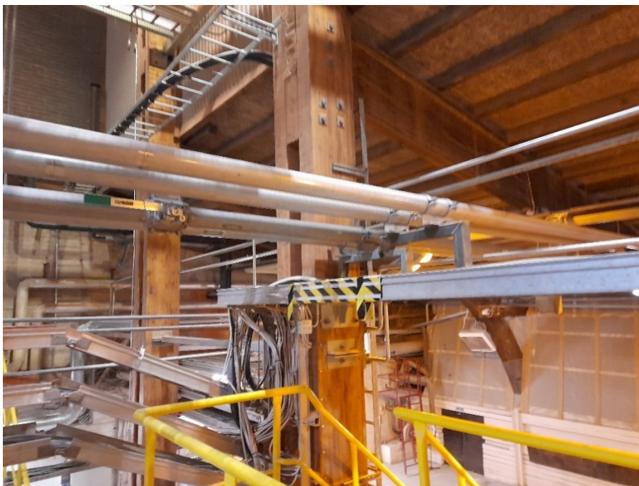
Kuva 16. Ehdotettu paikka uudelle ilmapuhaltajalle ylempää kuvattuna.
