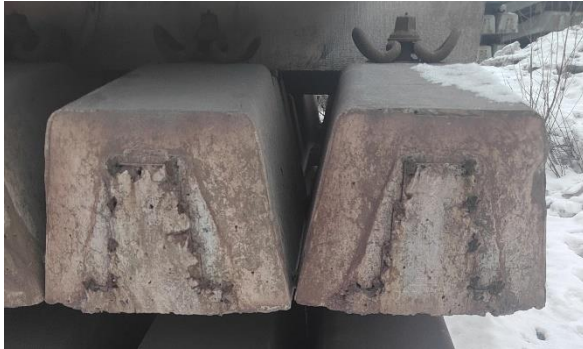
Kuva 14. Betoniratapölkky, SSAB Raahen
