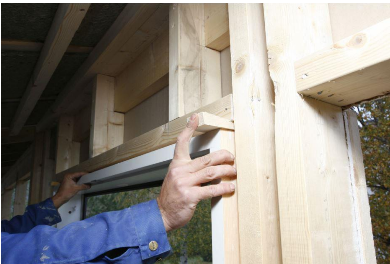
KUVA 11. Karmin yläkulmien kiristys kiiloilla (10)
