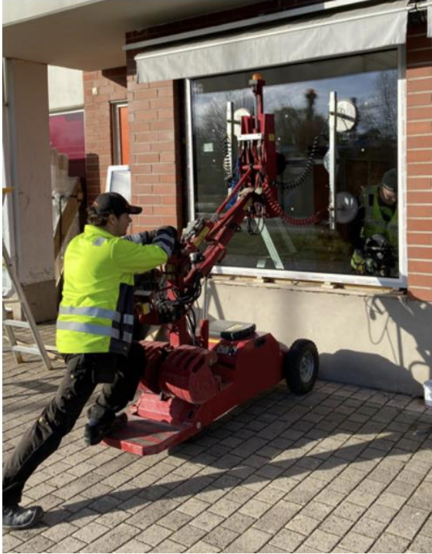
KUVA 14. Lasielementin paikoilleennosto nostokoneella (11)
