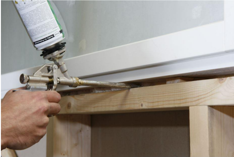
KUVA 13. Karmin ja seinän välisen raon tilkitseminen solumuovilla (10)
