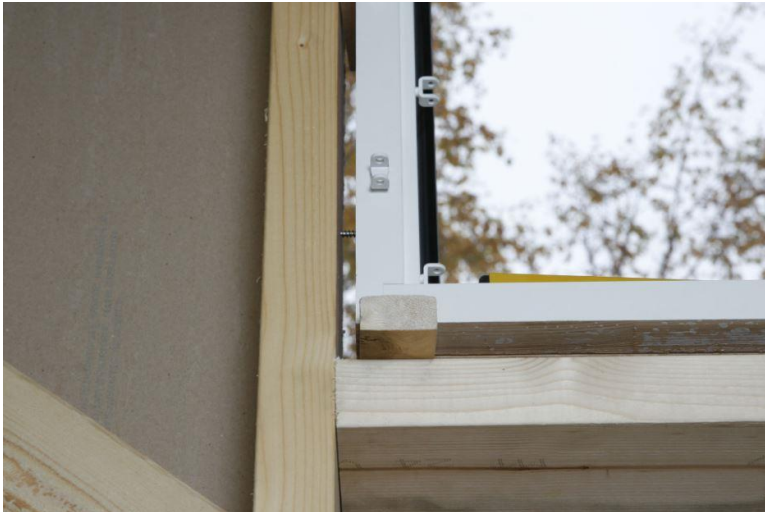
KUVA 12. Karmin kiinnitys ruuveilla (10)
