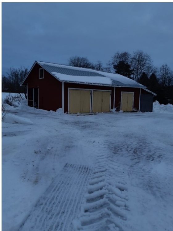
KUVA 18. Aurinkopaneelien asennuspaikka (Taina 2023)
