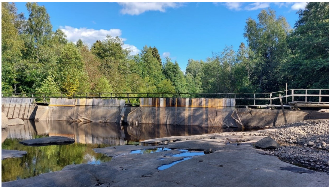
KUVA 2. Voimalaitoksen pato korjauksen aikana (Taina 2023)
