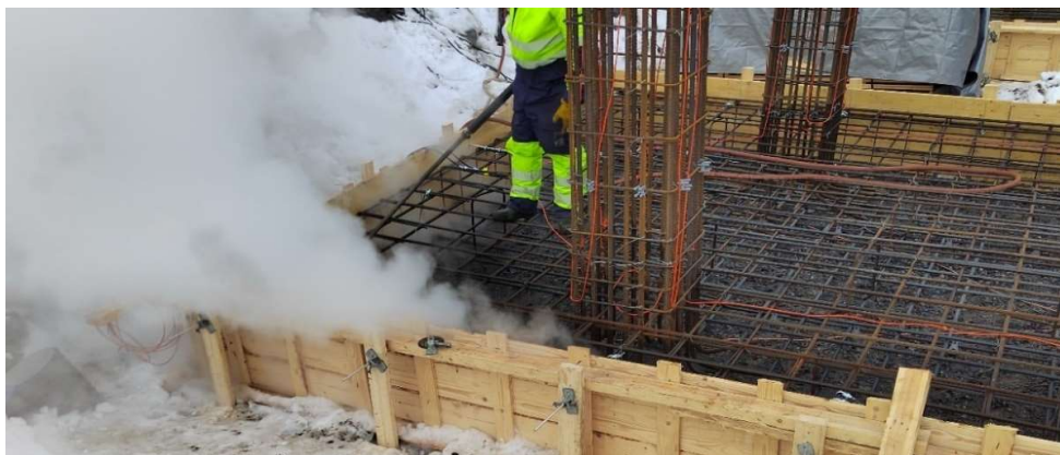
Kuva 9: Perustuslaatan höyrytystä. (Sanna Lähtölä)
