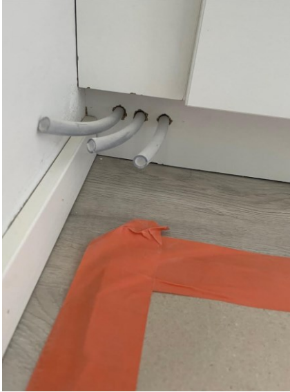
Kuva 8. Vuodonilmaisinetkujen peitelevy asentamatta.
