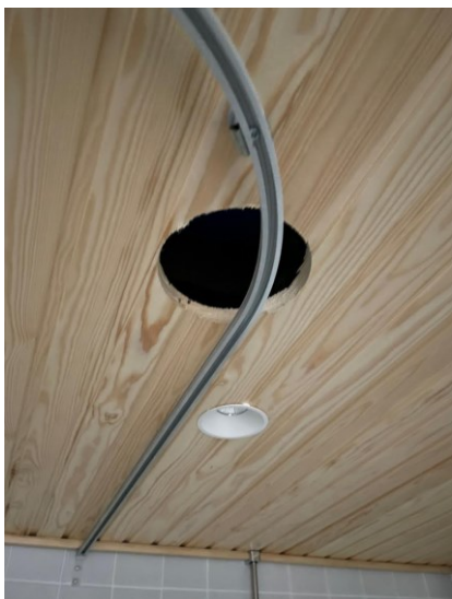
Kuva 6. Poistoilmaventtiili puuttuu.
