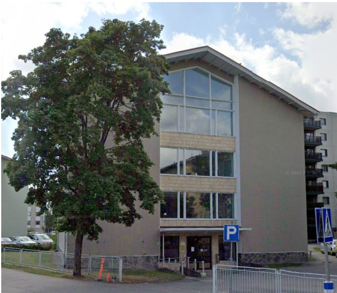
Kuva 2. Referenssikohteen julkisivu, Mannilantie 14.
