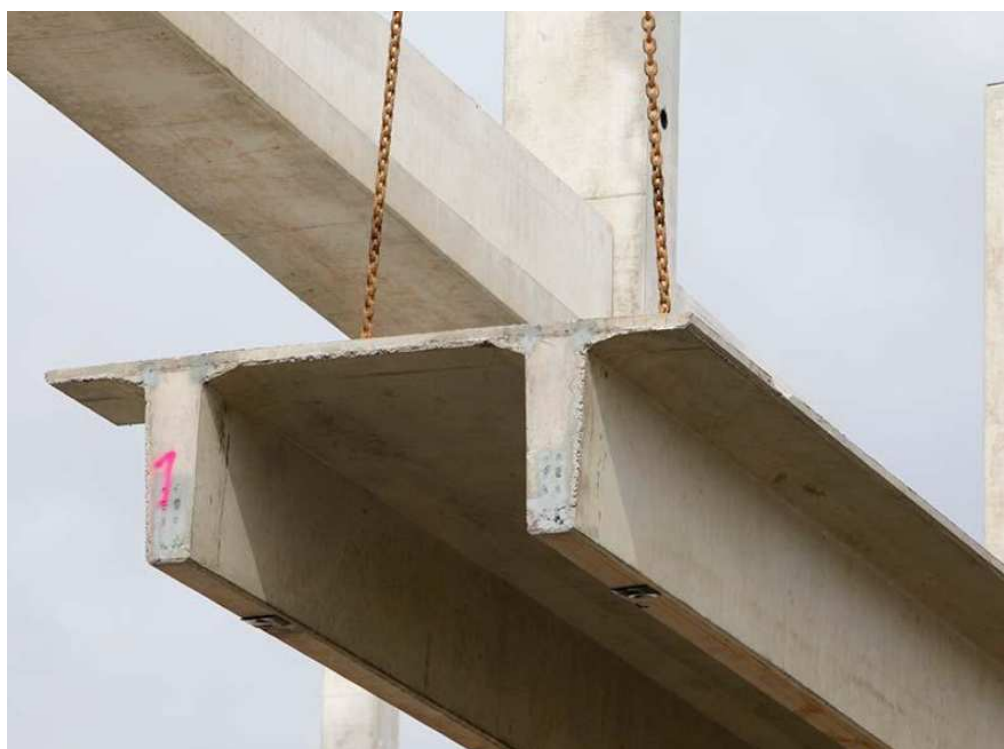
KUVA 25. TT-laatta asennuksessa (Betsset Oy:n nettisivut, julkaisuaika tuntematon)
