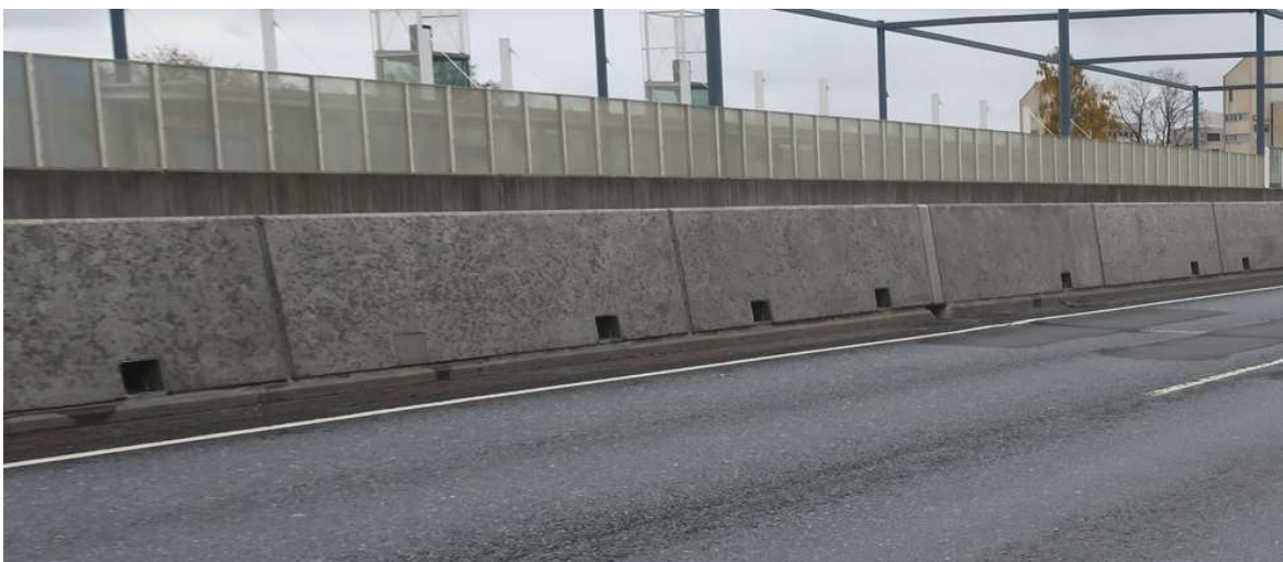
Kuva 6. Betonielementtikaide R15/DK 10 (Kapanen 2019)
