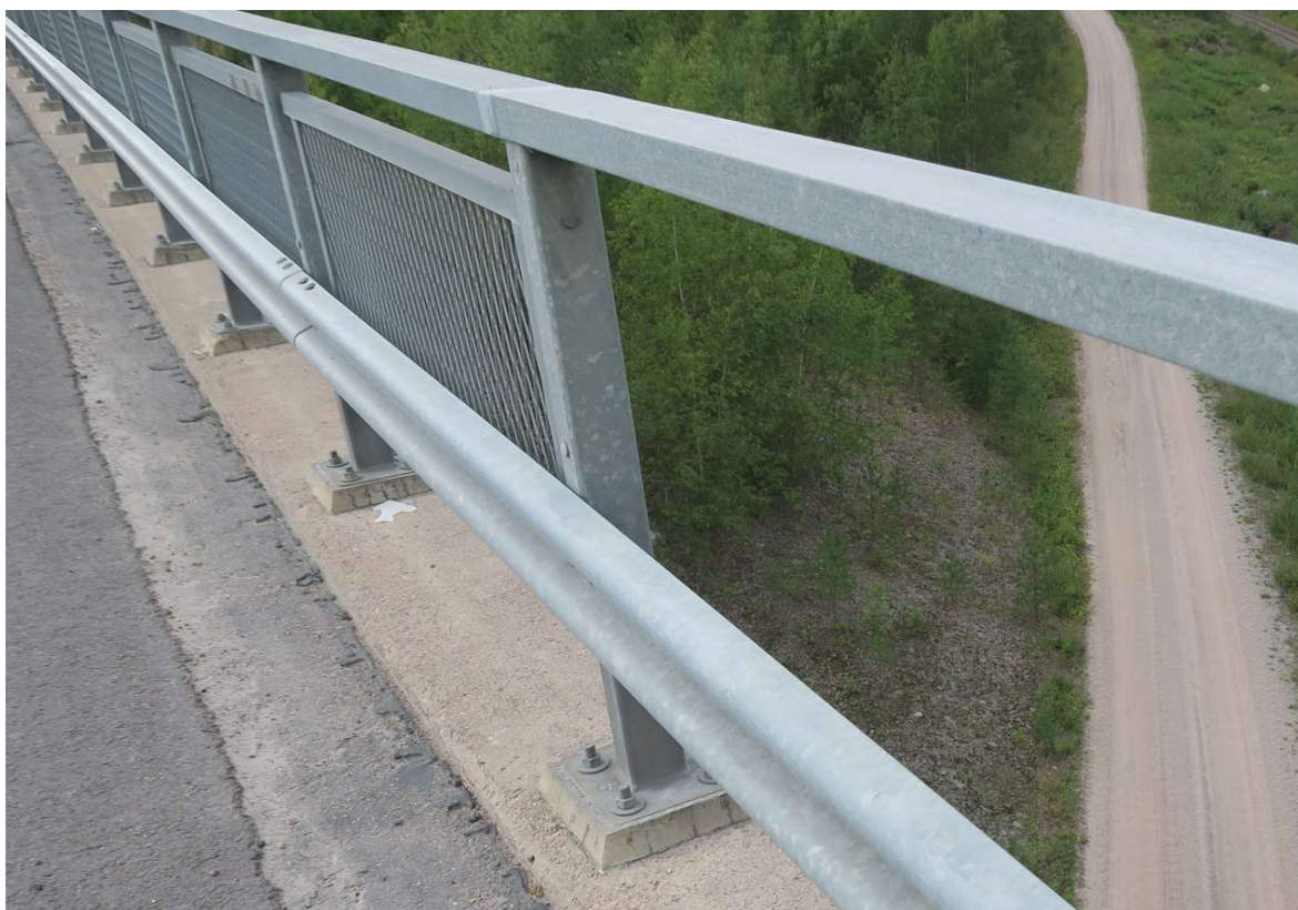
Kuva 4. Pulttikiinnitteinen teräskaide R15/DK 1 (Kapanen 2018)
