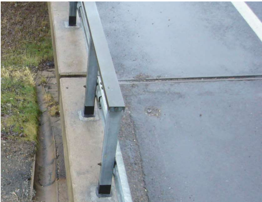
Kuva 5. Upottamalla kiinnitetty teräskaide R15/DK 1 (TREX tietokanta 2005)
