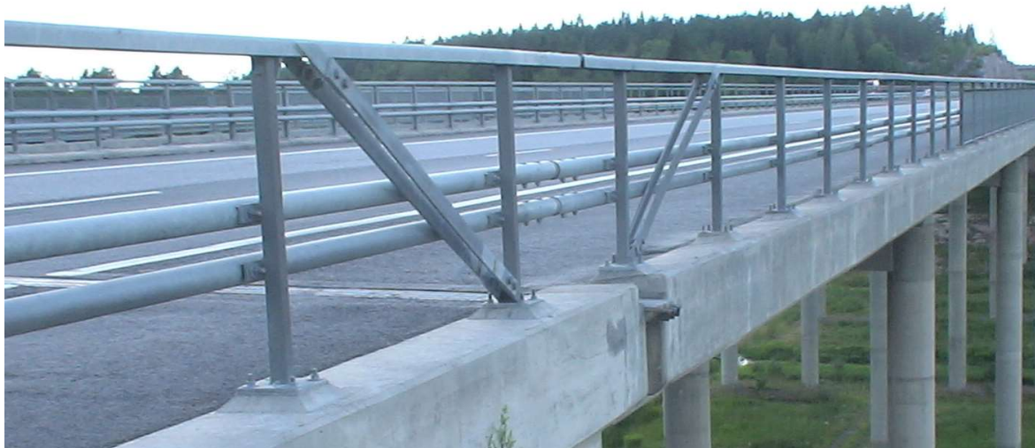
Kuva 3. H2-törmäyskestävyyssluokan teräskaide R15/DK H2 (TREX tietokanta 2014)
