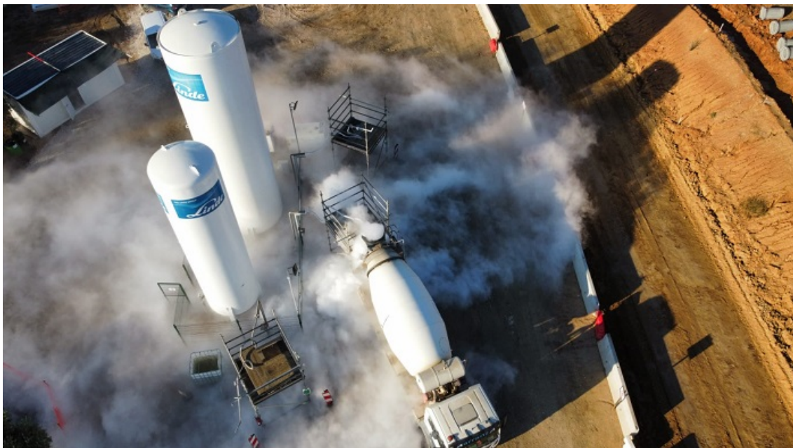
KUVA 13. Typpisiilot ja betoniauto työmaalla (20)
