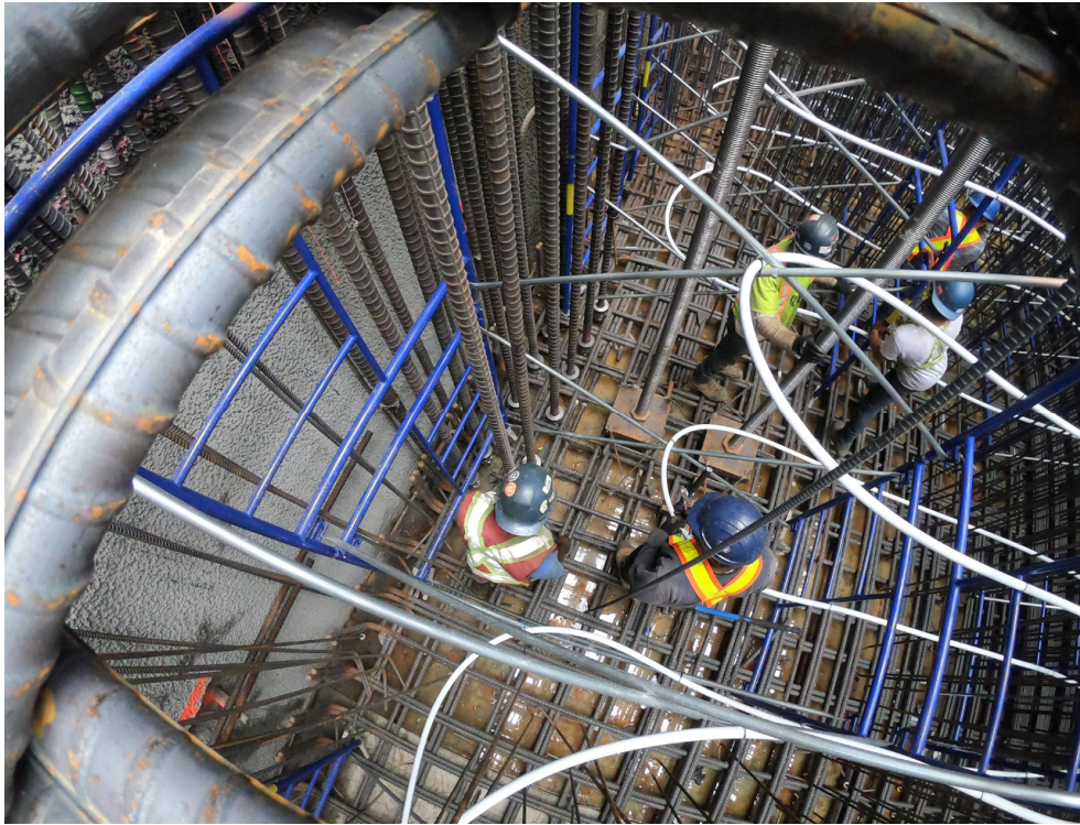
KUVA 17. Putkistojäähdytyksen asennus massiiviseen rakenteeseen (25)
