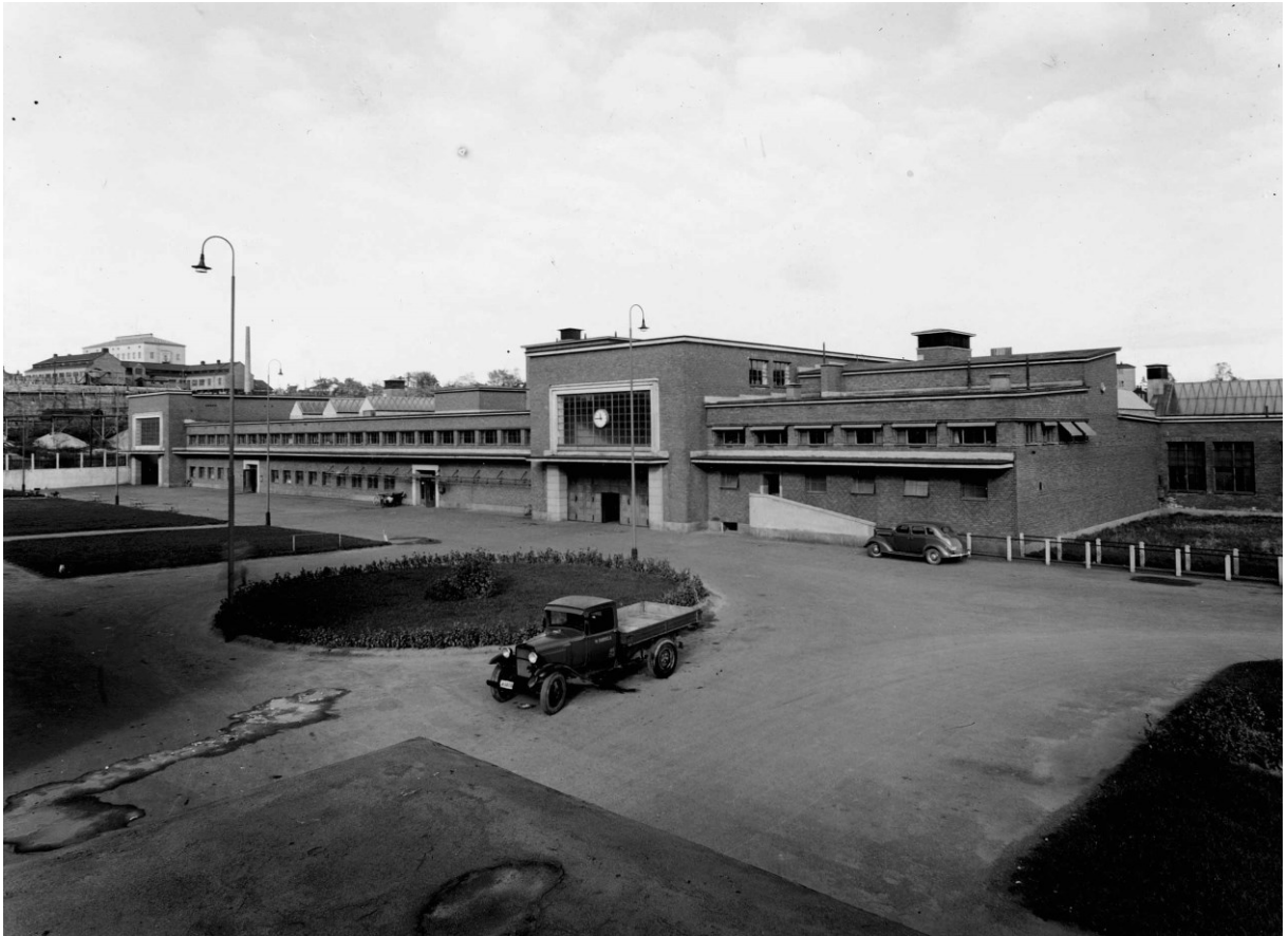
Kuva 3. 1933 valmistunut teurastamolaitos (Teurastamo, n.d.)
