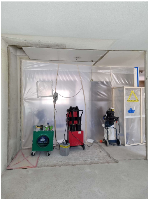
Kuva 15. Kuvassa asbestityön osastointi ja alipaineistuslaitteet.
