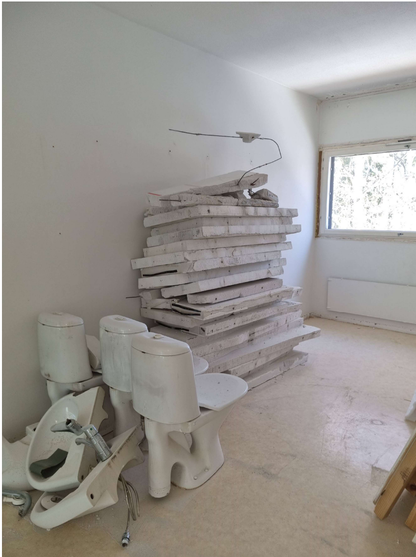
Kuva 14. Kuvassa Siporex-seinät sekä WC-varusteet purettuna.
