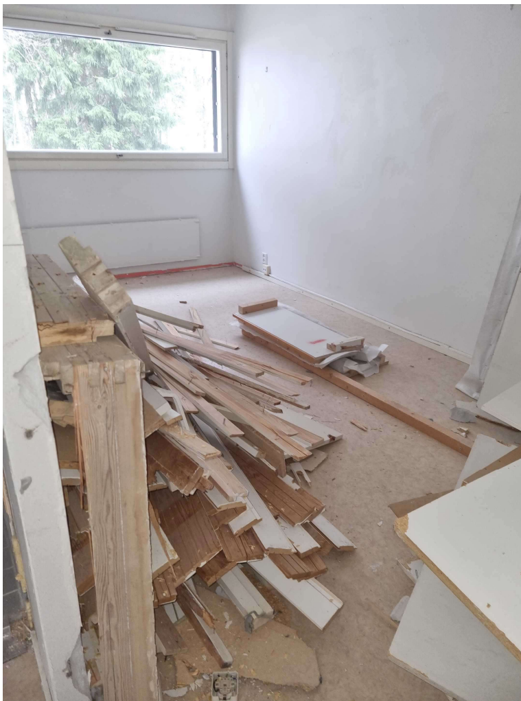
Kuva 12. Kuvassa paneelit, listat ja kalusteet purettuina.
