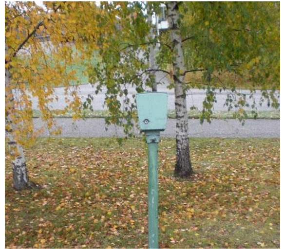
Kuva 6. Vanha autolämmitysrasia
