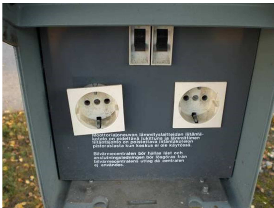
KUVA 7. Pistorasia on irti autolämmitysrasiasia
