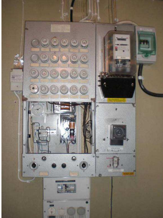
KUVA 3. Kosketussuojaus puutteellinen
