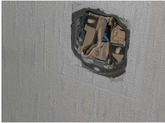
KUVA 11. Asukkaan rikkiäinen pistorasia
