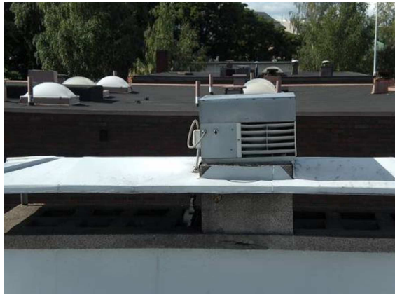
KUVA 9. Jakorasia irti poistoilmakoneesta
